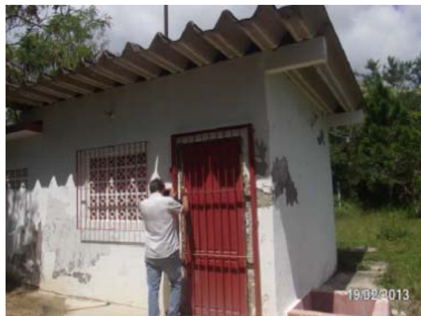
Imagem 16: ETA com gradeamento, mas sem identificação. Pintura necessita de reparos.
