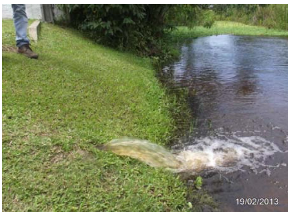
Imagem 44: Descarga de rede, no final da Rua da Praia (Rua 2001). Nota-se coloração amarelada da água, devido presença de ferro e manganês.
