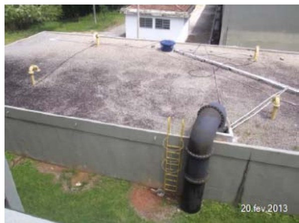
Imagem 55: Tanque de contato da ETA Morro dos Quadros onde é dosado o cloro, o flúor e o cal.. Fiação exposta.
