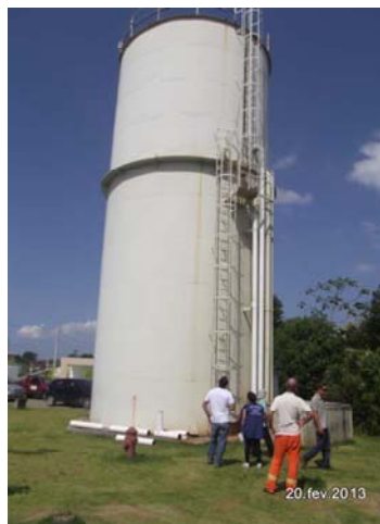
Imagem 77: Reservatório do Condomínio terra Nova.
