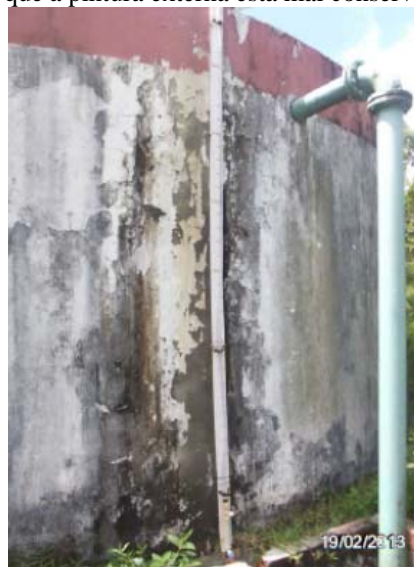
Imagem 20: Reservatório junto a ETA com infiltração. Régua de leitura de nível apagada, com dificuldade para leitura.
