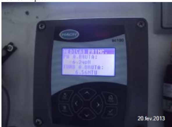
Imagem 60: Equipamento de medição de PH e Turbidez da água bruta.
