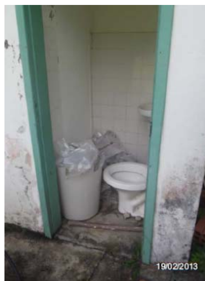
Imagem 18: Banheiro com acúmulo de resíduos. Nota-se que a pintura externa está mal conservada.
