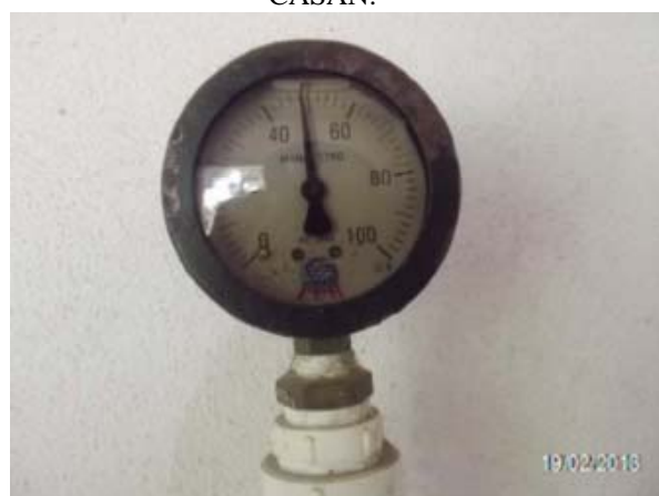
Imagem 37: Manômetro na saída da ETA
