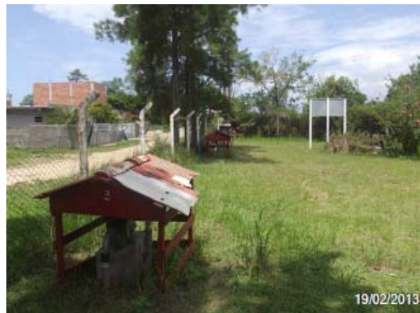
Imagem 27: Ponteiros de Captação de água da ETA da Pinheira.
