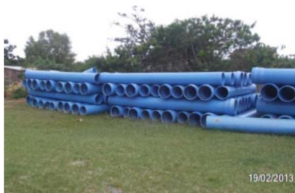
Imagem 49: Tubulações da rede adutora da nova ETA a ser implantada no local. Tubulação exposta a intempéries e armazenada em local com acúmulo de água o que deteriora a junta elástica presente na tubulação
