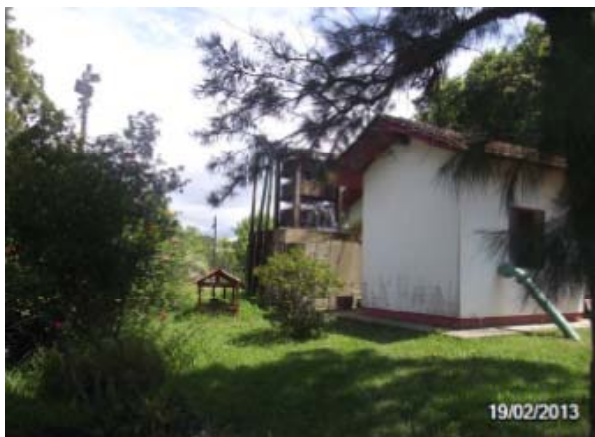
Imagem 26: ETA da Pinheira
