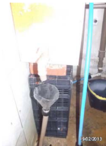
Imagem 8: Dosagem de flúor por gotejamento.
