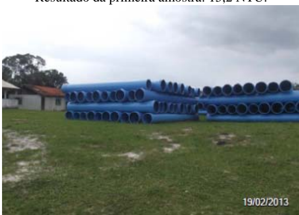
Imagem 48: Local onde será instalado a nova ETA. No local encontram-se apenas as tubulações para a rede adutora, expostas a intempéries e sem nenhuma proteção.
