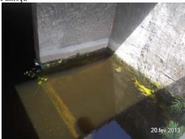
Imagem 52: Caixa de entrada da água bruta vinda de Pilões e Cubatão, que no momento da fiscalização estava sem funcionamento. Verifica-se a necessidade de limpeza devido à presença de limo e vegetação nas estruturas..
