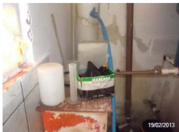
Imagem 10: Dosagem de bicarbonato de cálcio, também é realizada por gotejamento (mangueira azul).
