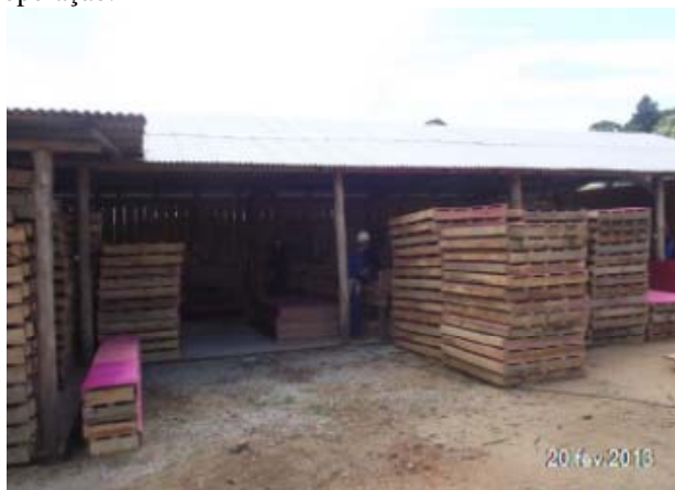
Imagem 66: Canteiro de obras da reforma e ampliação da ETA de Morro dos Quadros.
