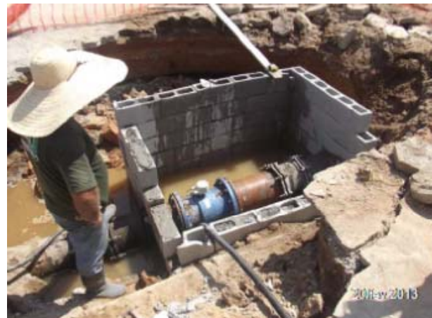
Imagem 75: Macromedidor Passa Vinte – obras para construção da caixa de proteção e instalação da telemetria.
