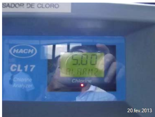
Imagem 62: Equipamento de medição de cloro.
