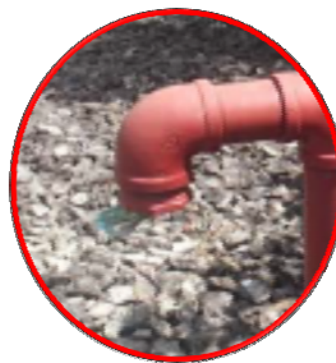
Imagem 22: Detalhe da tela da tubulação de ventilação danificada.
