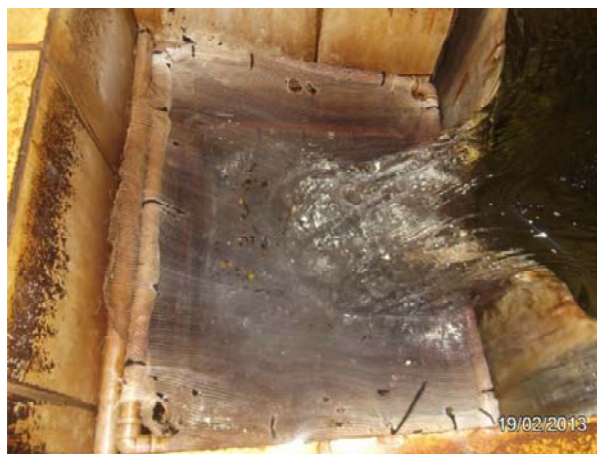
Imagem 4: Gradeamento para remoção de sólidos em suspensão.
