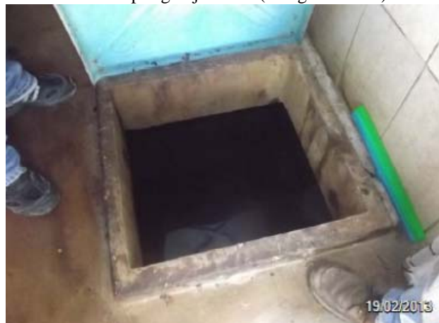
Imagem 12: Tanque de contato. Recebe todos os produtos químicos utilizados no tratamento
