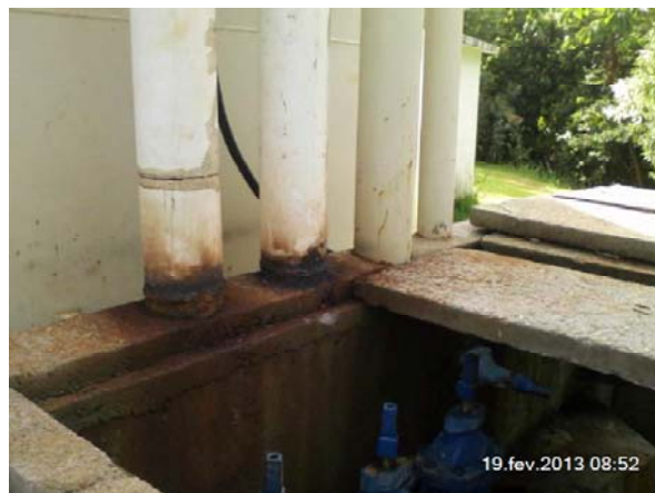
Imagem 79: Imagem encaminhada à ARIS por condômino, através da Ouvidoria mostra as tubulações do reservatório oxidadas. (Data 19/03/2013).
