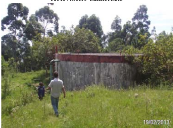
Imagem 23: Há necessidade de limpeza e capina no entorno do reservatório.
