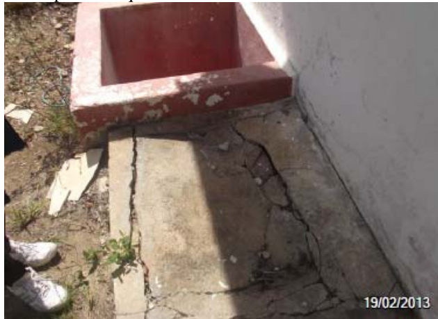
Imagem 14: Calçada da ETA danificada.
