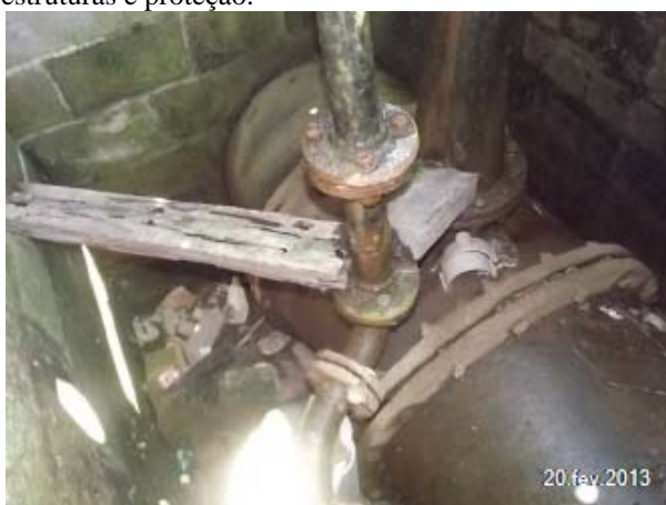
Imagem 70: Macromedidor Jaqueira - instalação do macromedidor na tubulação de adução. Escoras improvisadas na tubulação. Falta limpeza e manutenção.
