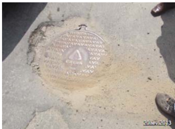
Imagem 73: Macromedidor Pacheco – esquina da Rua José Fernandes Garcia – Bairro Aririú.
