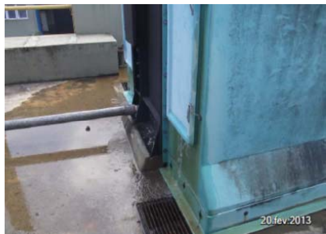
Imagem 53: Peneira rotativa de água bruta em operação
