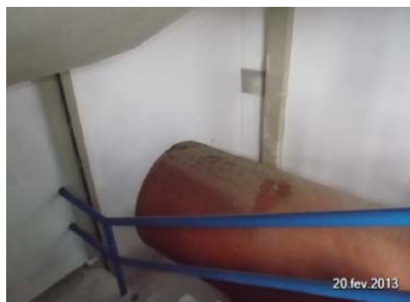
Imagem 59: Adutora de água bruta que abastece os filtros com oxidação.
