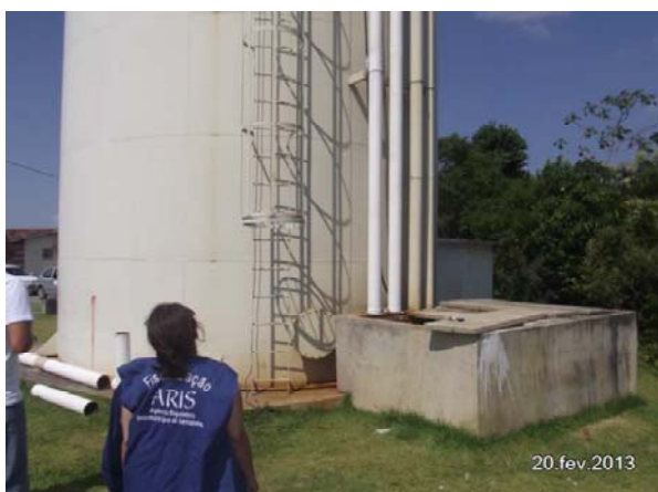
Imagem 80: Evidência da pintura da tubulação do reservatório para disfarçar a oxidação.
