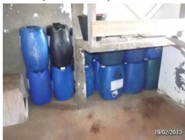
Imagem 29: Tina de preparo de hipoclorito de sódio apoiada de forma improvisada.
