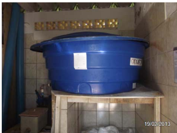
Imagem 3: Tina de preparo de cloro.
