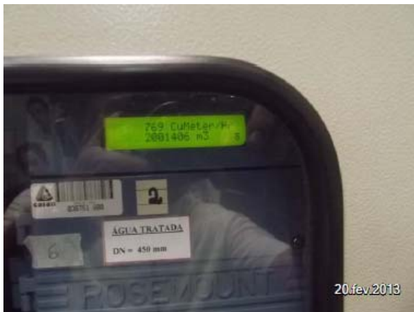
Imagem 56: Macromedidor de água tratada da adutora de 450 mm de diâmetro que abastece o município de Palhoça, localizado na ETA Morro dos Quadros.
