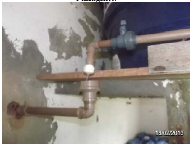
Imagem 30: Dosagem de hipoclorito realizada com tecnologia defasada. Nota-se também, a estrutura da casa de química mal conservada.
