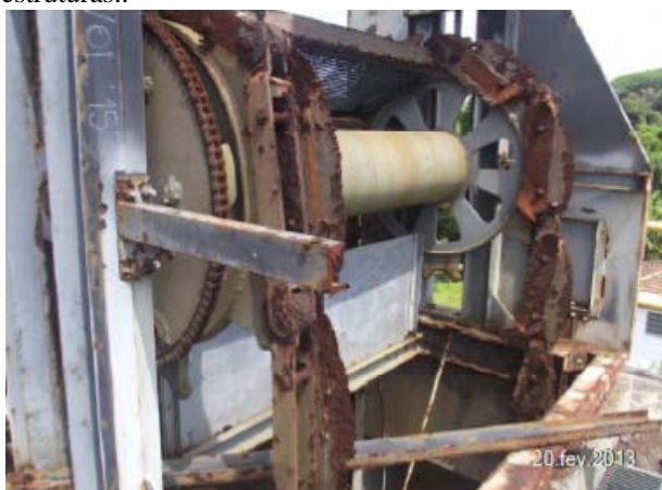
Imagem 54: Peneira rotativa de água bruta desativada e em altamente oxidada. Será substituída.
