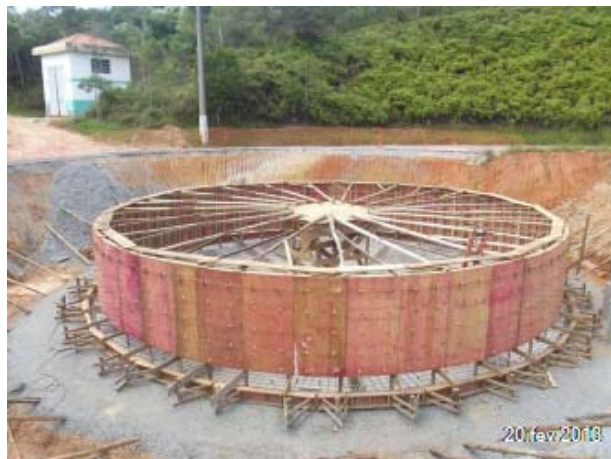
Imagem 67: Obra de construção do adensador de lodo.
