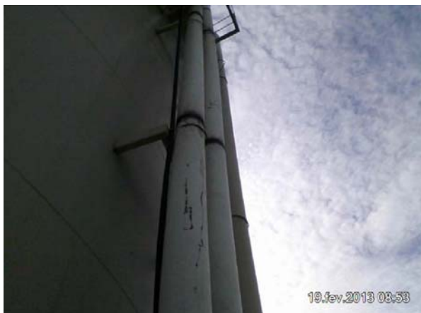
Imagem 78: Imagem encaminhada à ARIS por condômino, através da Ouvidoria mostra as tubulações do reservatório oxidadas. (Data 19/03/2013).
