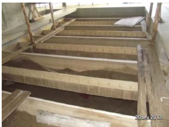
Imagem 64: 4 (quatro) filtros desativados que estão sendo reformados e que devem retornar para a operação.
