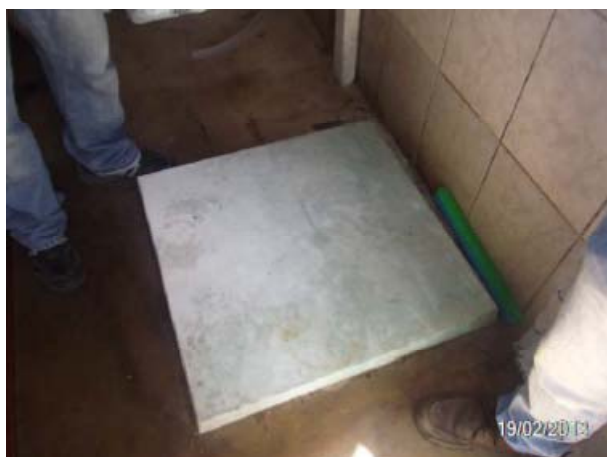
Imagem 11: Tampa do tanque de contato em bom estado de conservação.
