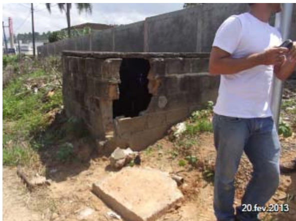
Imagem 68: Macromedidor Jaqueira – sem nenhum tipo de identificação e necessidade de melhorias nas estruturas e proteção.
