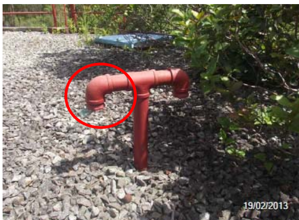
Imagem 21: Tela da tubulação de ventilação do reservatório danificada.
