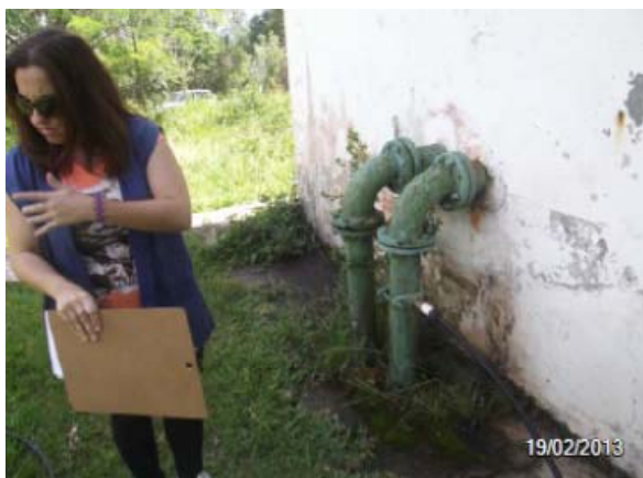
Imagem 15: Calçada da ETA com infiltração junto a tubulação de adução de água bruta. Pintura mal conservada.
