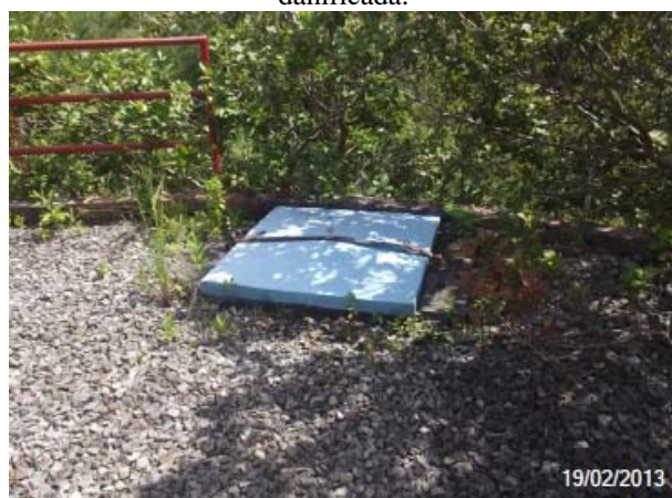
Imagem 24: Tampa de inspeção do reservatório com cadeado. Há vegetação crescida na superfície do reservatório.
