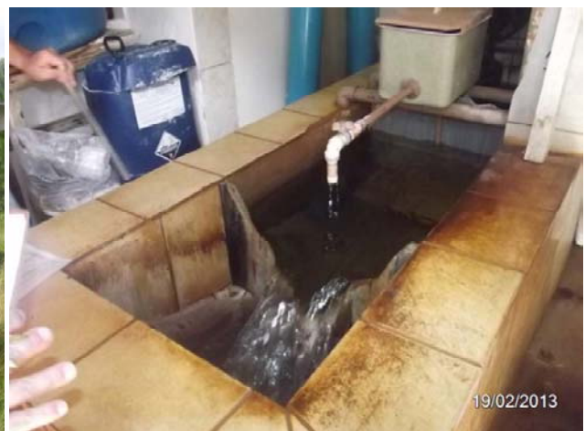
Imagem 2: Sistema de dosagem de cloro por gotejamento.
