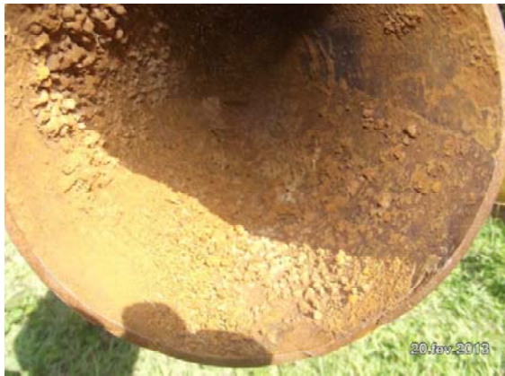
Imagem 82: Tubulação do sistema que foi trocada. Nota-se claramente a oxidação do material e a incrustação em seu interior.
