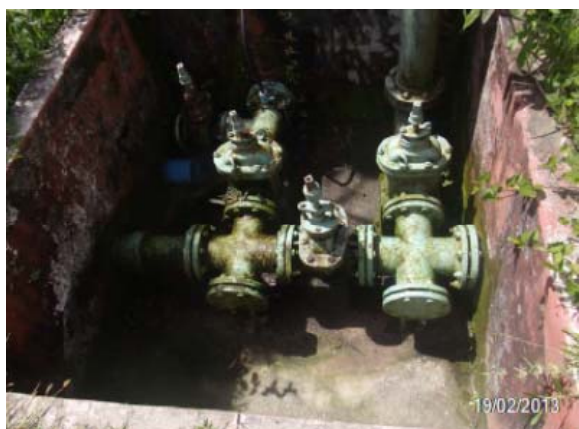
Imagem 25: Registros do reservatório com vazamento.
