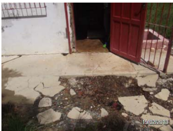
Imagem 17: Calçada danificada na entrada da ETA..
