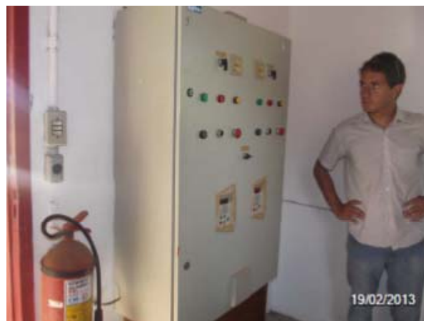
Imagem 35: Painel de comando da ERAT. No canto esquerdo da foto, extintor de incêndio oxidado, com data de validade vencida e selo de patrimônio CASAN.
