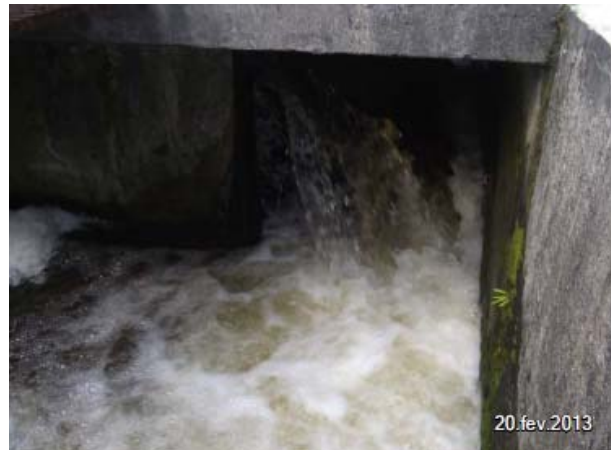
Imagem 51: Caixa de entrada da água bruta vinda de Pilões e Cubatão. Verifica-se a necessidade de limpeza devido à presença de limo nas estruturas.
