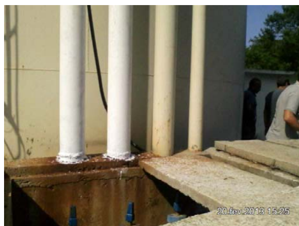
Imagem 81: Evidência da pintura da tubulação do reservatório para disfarçar a oxidação
