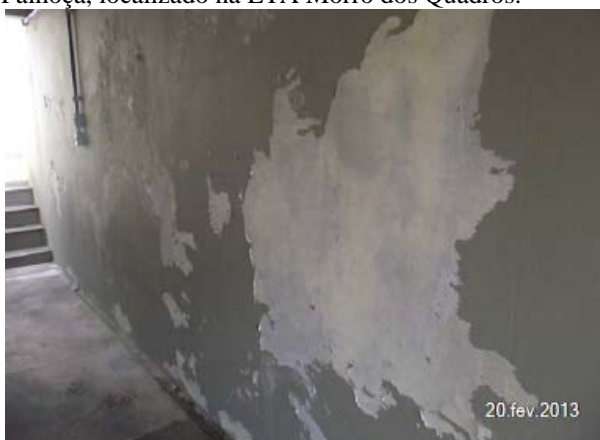
Imagem 58: Estruturas da ETA necessitando de pintura e conservação.
