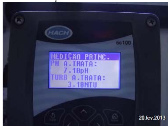
Imagem 61: Equipamento de medição de PH e Turbidez da água tratada No momento da fiscalização, turbidez de água tratada medida em 3,10 NTU, acima do exigido pela Portaria/MS n. 2.914/2011.
