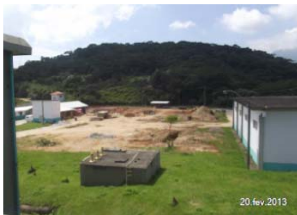
Imagem 65: Obras de melhorias na ETA de Morro dos Quadros.
