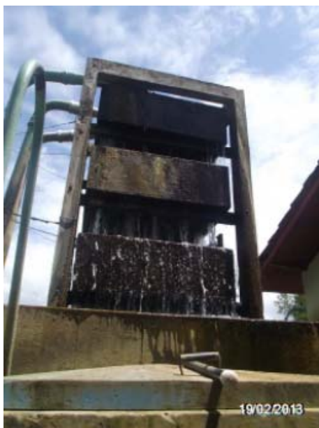
Imagem 28: Filtro de carvão ativado para remoção de ferro e manganês.
