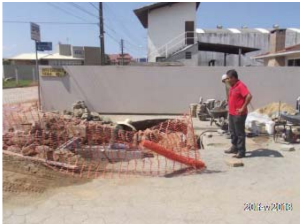
Imagem 74: Macromedidor Passa Vinte em obras. Localizado na esquina da Rua Getúlio Vargas – Jardim Eldorado.
