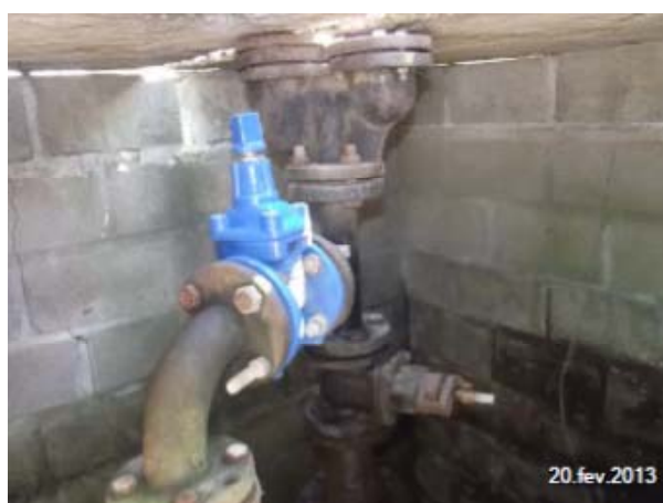
Imagem 71: Macromedidor Jaqueira - instalação do macromedidor na tubulação de adução..
