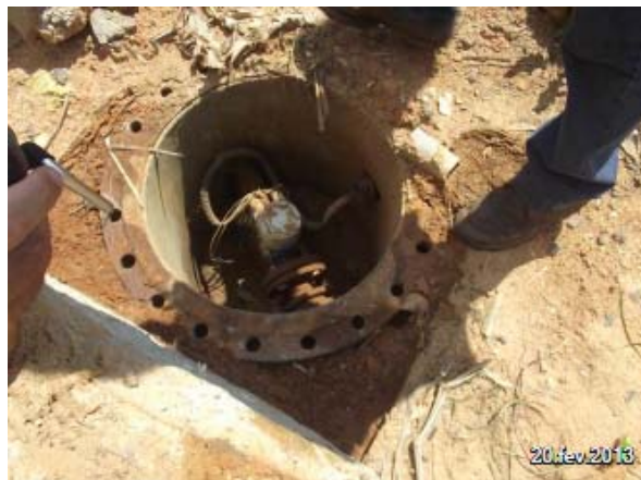
Imagem 69: Macromedidor Jaqueira. Sem conservação e manutenção.
