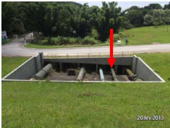
Imagem 50: Adutoras de água tratada na Saída da ETA de Morro dos Quadros que abastece a Grande Florianópolis. A Adutora sinalizada é a de 450 mm de diâmetro que abastece unicamente o município de Palhoça
