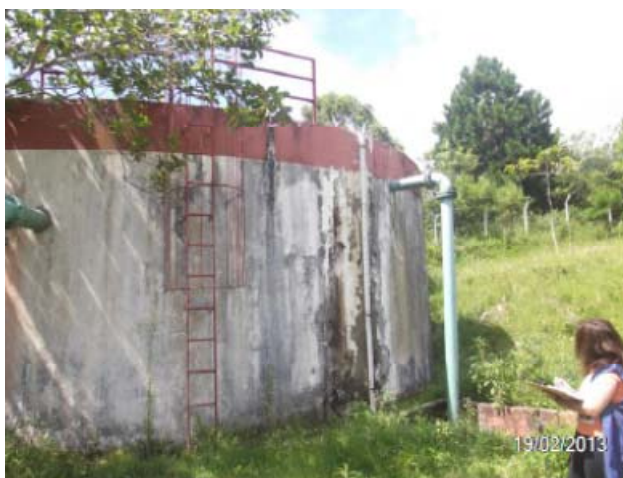
Imagem 19: Reservatório junto a ETA em mal estado de conservação e com infiltração. Sem identificação.
