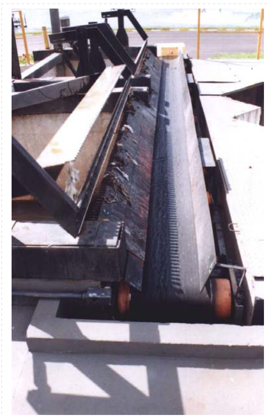
Figura 2 – Sistema de remoção automática do detritos removidos no gradeamento com espaçamento de 20 mm e canal de distribuição do esgoto bruto para as caixas de areia.
