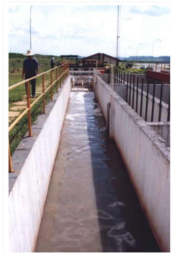
Figura 2 – Sistema de remoção automática do detritos removidos no gradeamento com espaçamento de 20 mm e canal de distribuição do esgoto bruto para as caixas de areia.
