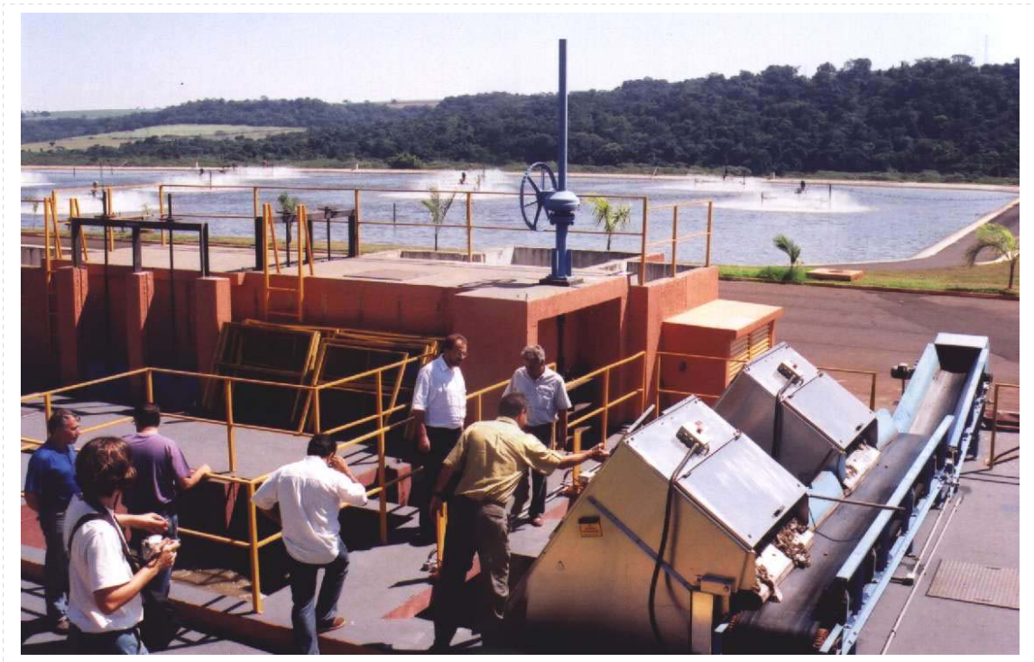
Figura 3 - Foto ilustrando a peneira para retenção de sólidos de 6 mm juntamente com a esteira para remoção automática dos detritos encaminhando para uma caçamba.
