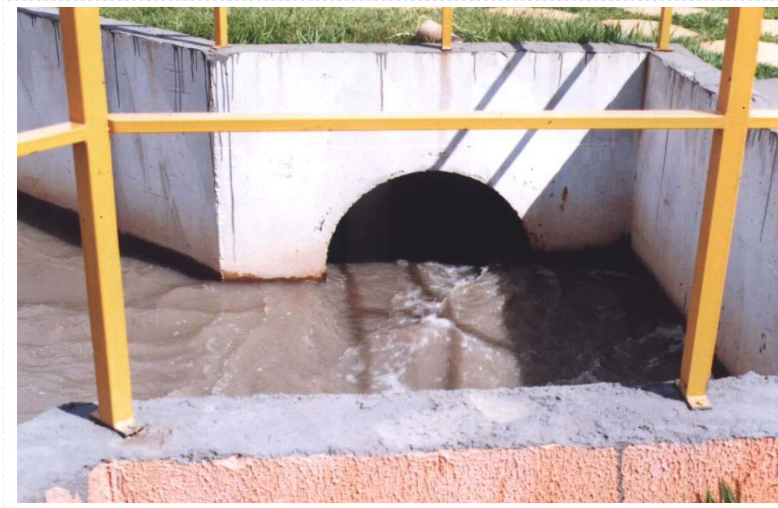
Figura 1 - Foto ilustrando a chegada do esgoto bruto na ETE-Araraquara.
