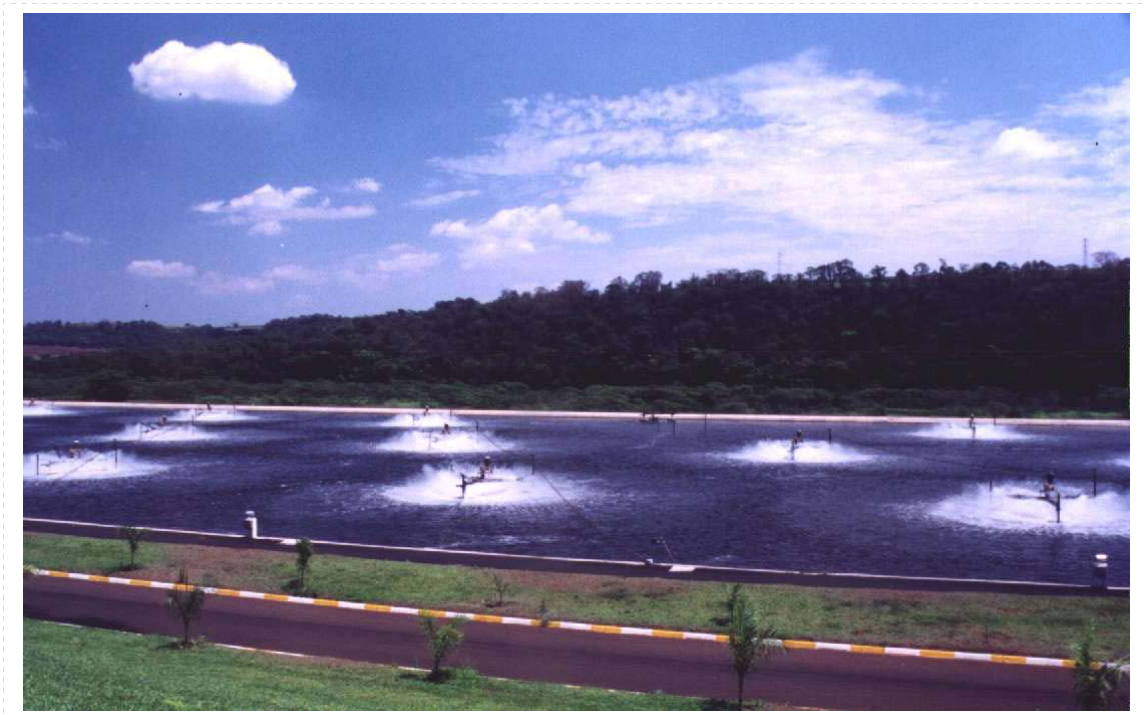
Foto 4 - Foto ilustrando a Lagoa de Aeração da ETE-Araraquara, constituída por aeradores superficiais com potência de 40 cv.
