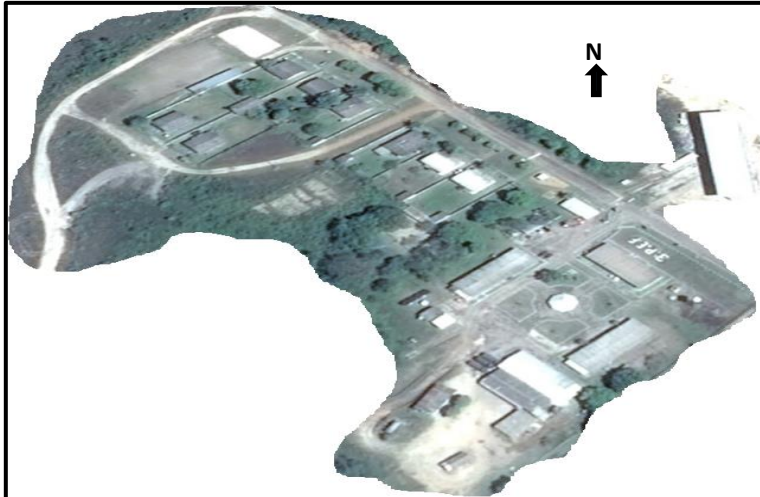
Figura 45 - PEF Pacaraima e a disposição das edificações
