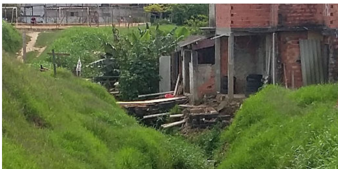
Figura 5 – Esgoto lançado no afluente do Ribeirão Cocaia por meio de ligações clandestinas.
