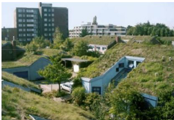
Figura 4 – Telhados verdes em residências na Austrália. Fonte: Wilson, 2007 apud Rosseti, 2009.
