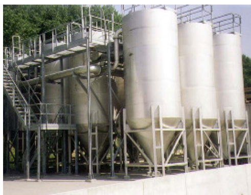
Figura 5.11 Esquema de un filtro de arena Dynasand®, (Iglesias, R.)
