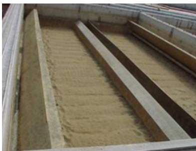
Figura 5.5 Filtro convencional, monocapa y de flujo descendente (Iglesias, R.)
