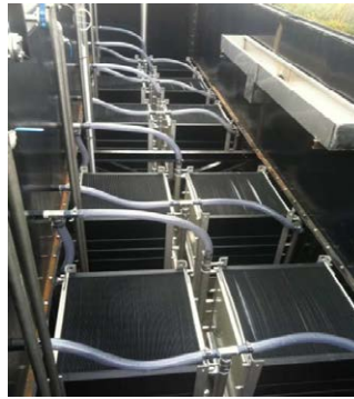
Figura 6.51 Tanque de membranas con conexiones de permeado y aire de limpieza, Alfa-Laval
