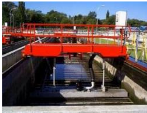
Figura 5.9 Esquema de funcionamiento de un filtro de puente móvil (Iglesias, R.)
