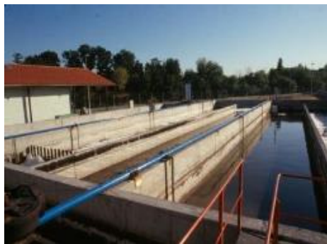
Figura 5.22 Laberinto de cloración de un tratamiento de desinfección (Iglesias R.)
