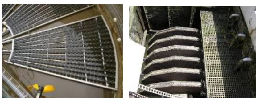
Figura 5.12 Dcha) Interior de uno de los discos que componen el filtro textil. Izda) Disposición de los discos dentro de la línea de tratamiento (Batanero, G.)
