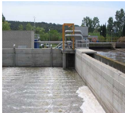
Figura 6.65 Tanque de laminación de La Bisbal, (ACA)
