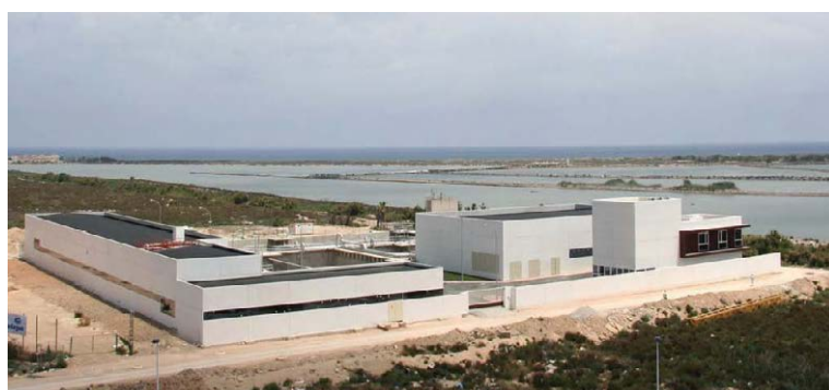
Figura 6.64 Vista general de la EDAR de San Pedro del Pinatar, (ESAMUR)
