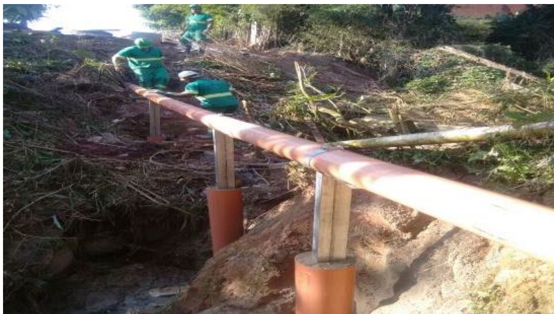
Figura 3: Imagem da obra realizada
