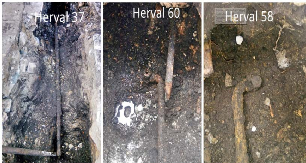
Figuras 7, 8 e 9: Ramais de ferro galvanizado substituídos concomitante a rede
