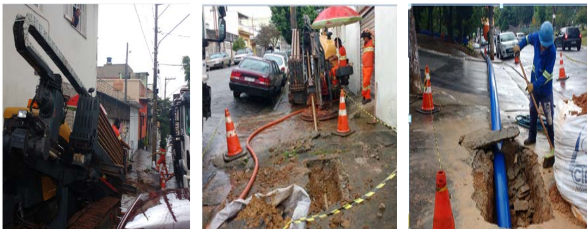
Figuras 7, 8 e 9 : Rede de distribuição de água sendo executada por método não destrutivo via HDD Furo direcional para ampliação de área coberta por válvula redutora de pressão
