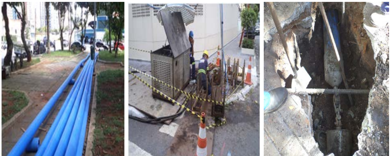
Figuras 4, 5 e 6 : Rede de distribuição de água sendo executada por método não destrutivo via pipebursting
