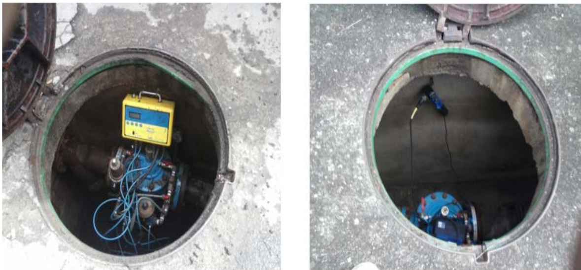
Figura 2: Exemplo de válvula redutora de pressão otimizada com antena de GPS para operação/regulagem a distância.
