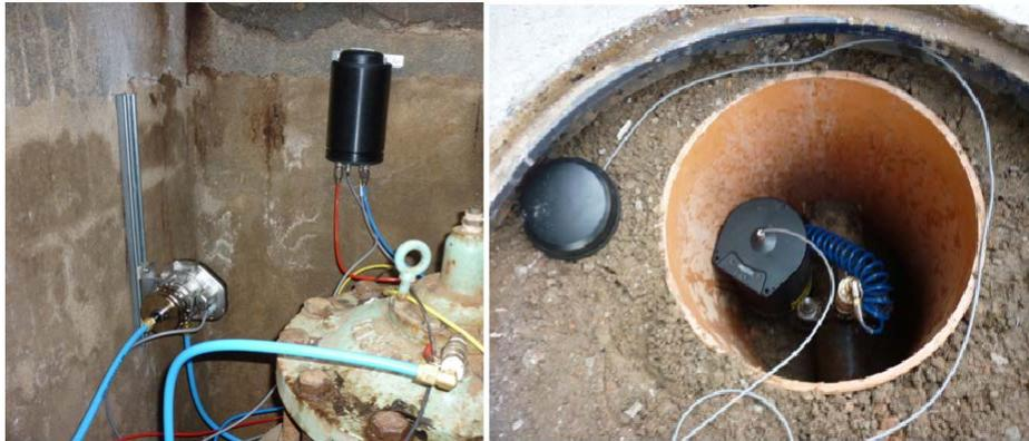
**Figura 2 – Controlador instalado na VRP Três Rios e datalogger no ponto crítico**
