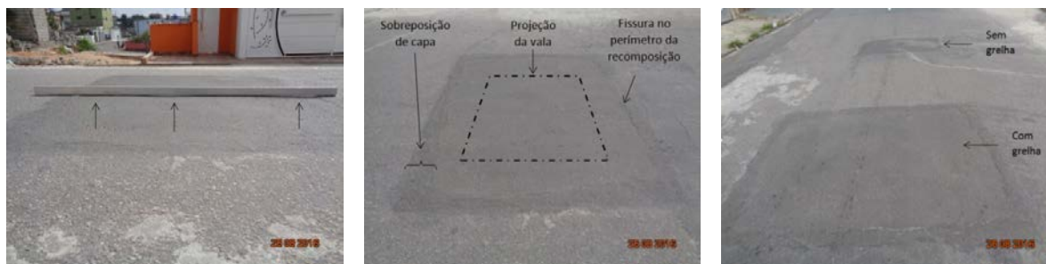
Figuras 5 a 7 – Vista da recomposição com e sem o reforço (Autores, 2016)
