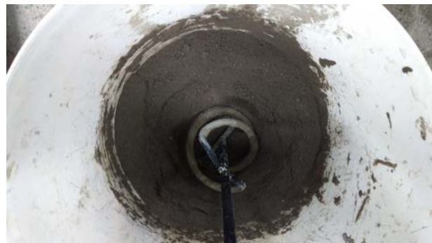
Figura 3 – Preparação do concreto
