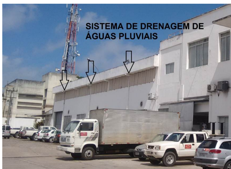
Figura 4. Sistema de drenagem de águas pluviais da edificação. Fonte: Silva (2016).
