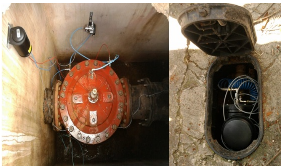
Figura 1: Controlador de VRP instalado no ponto crítico.
