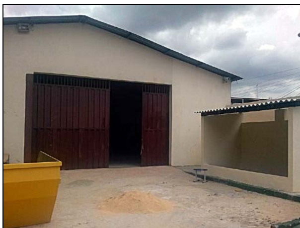
Figura 2: Foto frontal da entrada da UPRA (abrigo de resíduos à direita na foto e caçambas para acondicionamento de sucata metálica à esquerda na foto).
