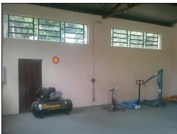
Figura 3: Espaço interno da UPRA e alguns equipamentos novos já entregues aguardando a instalação.
