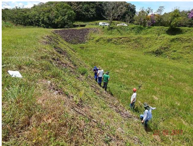
Foto 3: barragem Poço Preto do Sistema Rio Claro – inspeção realizada pelos próprios técnicos da Sabesp, sendo a barragem avaliada pelo Índice de Comportamento – IC.
