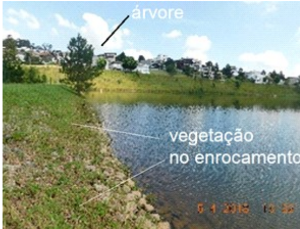
Foto 7: Barragem Morada dos Lagos do Sistema Aldeia da Serra, estrutura em destaque talude de montante.
