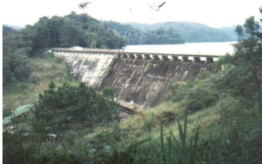
Foto 14: Barragem Ribeirão do Campo do Sistema Rio Claro vista geral.
