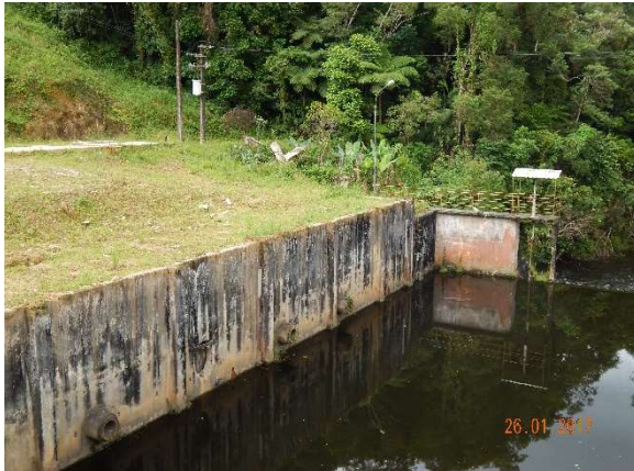
Foto 9: Barragem KM 78 do sistema Rio Claro, estrutura em destaque muro de aproximação.
