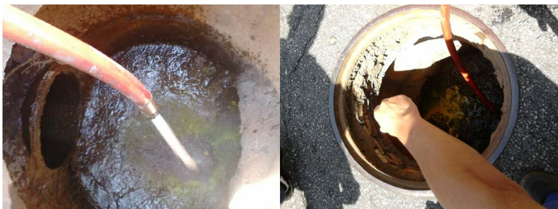
Foto 09 – Execução de teste de corante em redes de drenagem.
