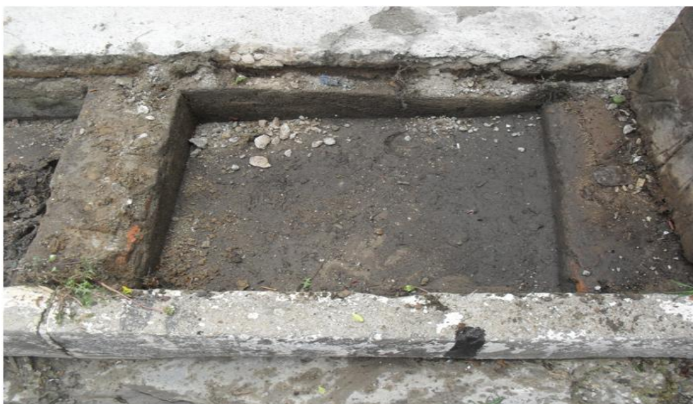
Foto 04 – Boca de Lobo assoreada.
