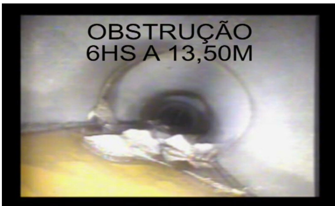
Foto 08 – Exemplo de interferência localizada durante filmagem da rede de drenagem.
