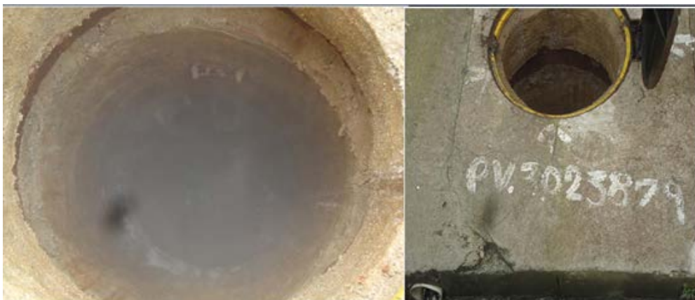
Foto 07 – Fumaça em rede de esgoto, durante teste nas redes pluviais.
