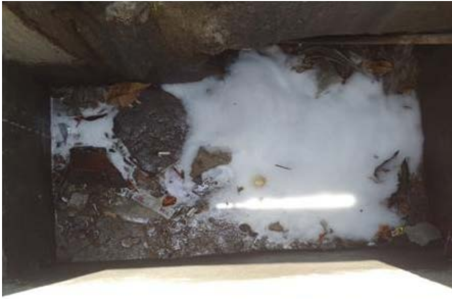
Foto 10 – Boca de Lobo, com contribuição de água cinza irregular.
