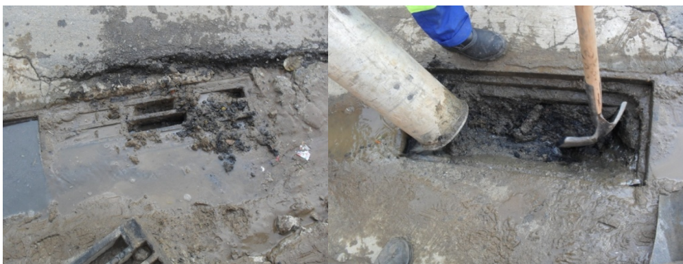
Foto 01 – Limpeza de Boca de Leão.
