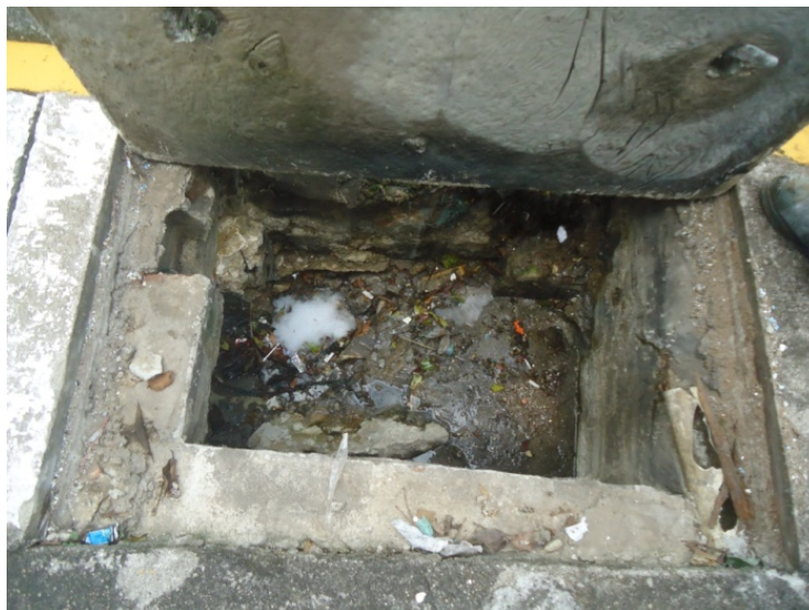
Foto – BLB com Ligação Irregular (Águas Cinza)
