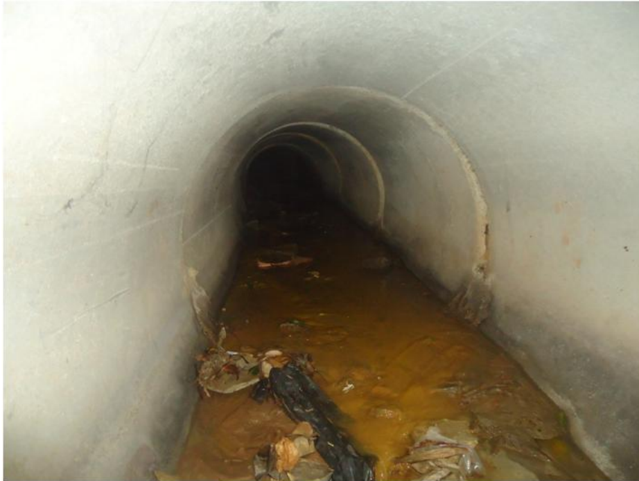
Foto 05 – Teste de Corante – Vista da Tubulação
