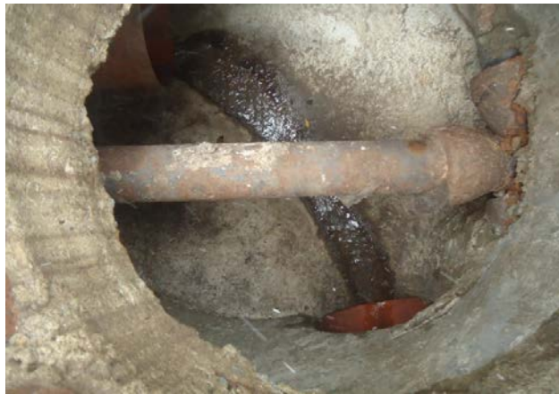
Foto – PV com tubulação de Água
