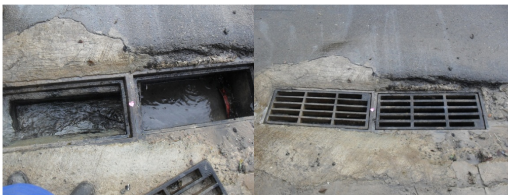
Foto 02 – Limpeza de Boca de Leão.
