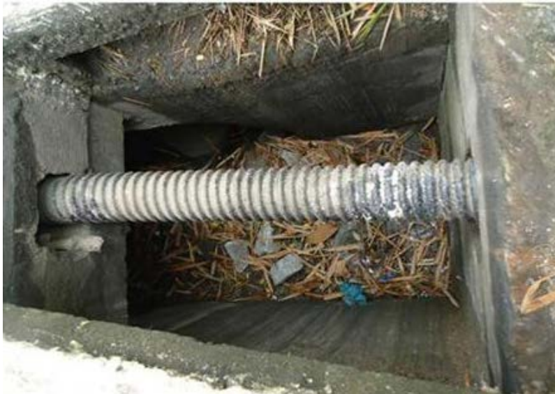
Foto 11 – Boca de Lobo, com interferência de tubulação.
