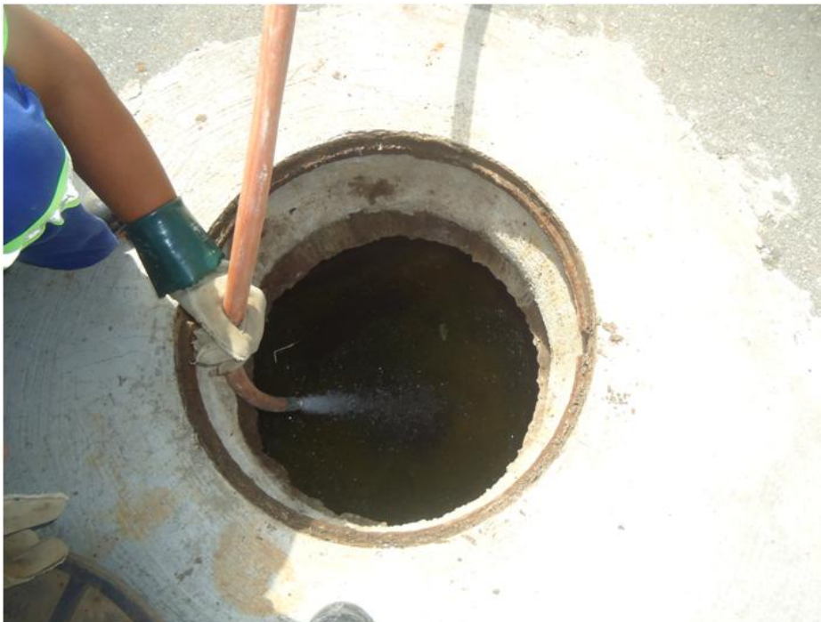
Foto 07 – Teste de Corante – Detalhe da Lavagem da Rede
