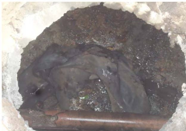
Foto – PV com tubulação e suspeita de esgoto
