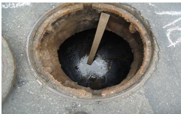
Foto 12 – Esgoto e efluentes interligados as redes de drenagem.
