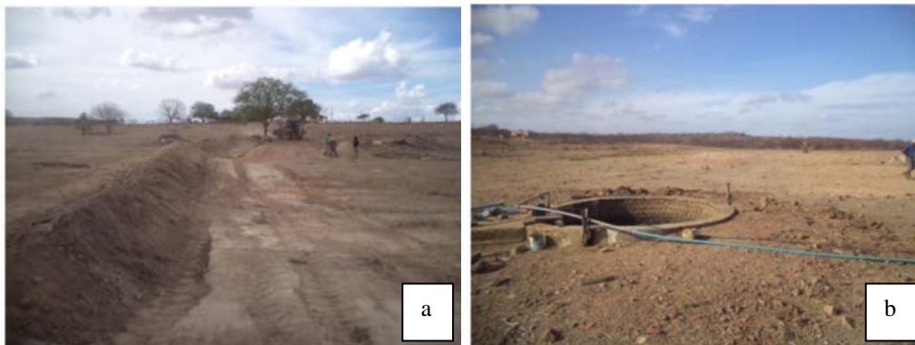
Figura 1 – Barragem subterrânea do sítio Boagua. (a) Barramento. (b) Poço amazonas.
