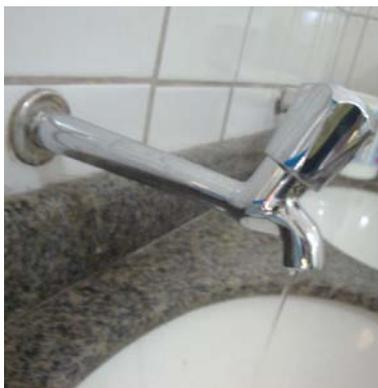
**Figura 6 – Exemplo de torneira com falta de estanqueidade no elemento de vedação**
