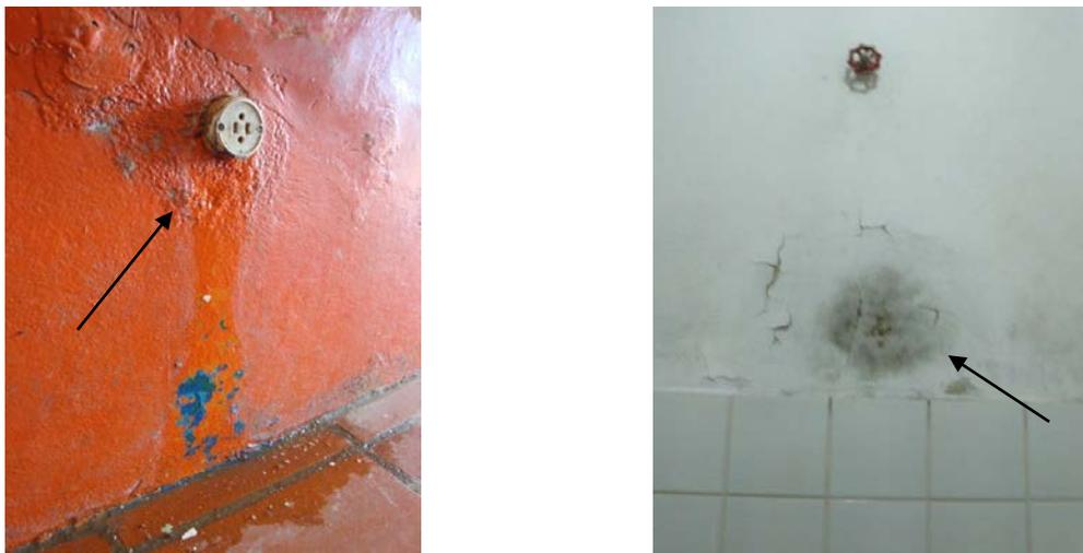
**Figura 11 – Indícios de vazamentos por fissura ou ruptura de tubulações embutidas**
