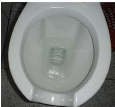
**Figura 8 – Exemplo de falta de estanqueidade nos aparelhos de descarga de bacias sanitárias**
