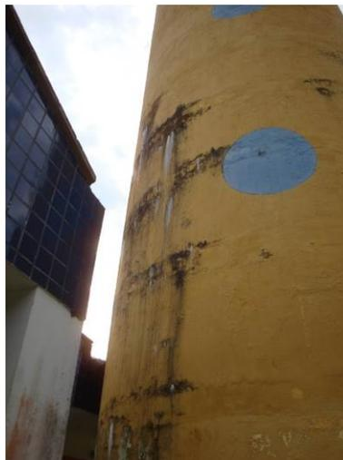
**Figura 10 – Reservatório não estanque**
