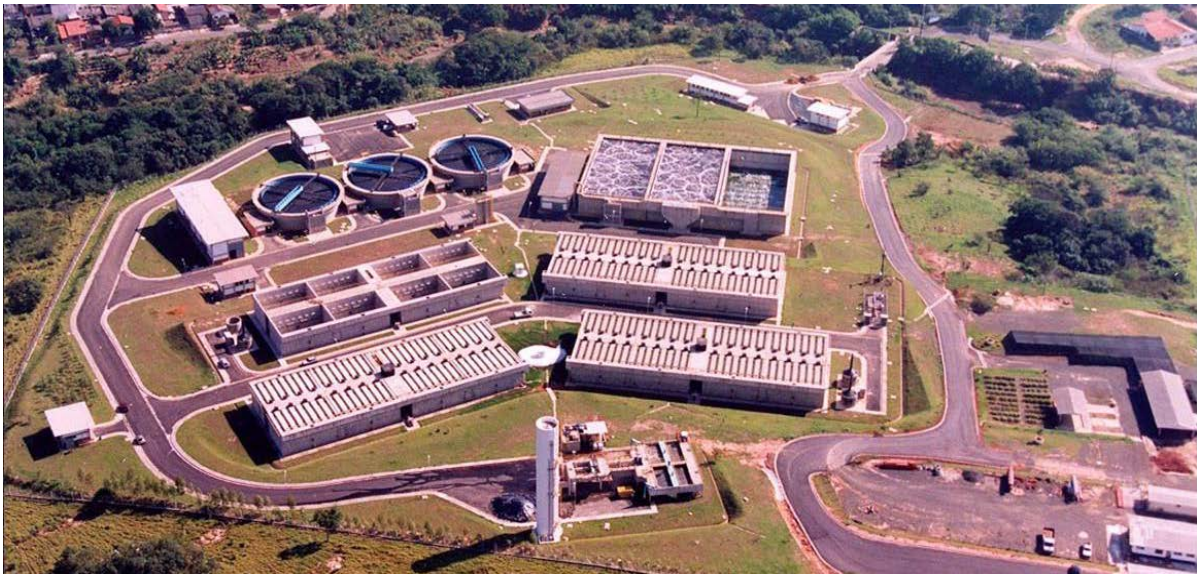
Figura 1 – Vista Aérea da ETE Piçarrão. Fonte: Arquivo Interno da SANASA
