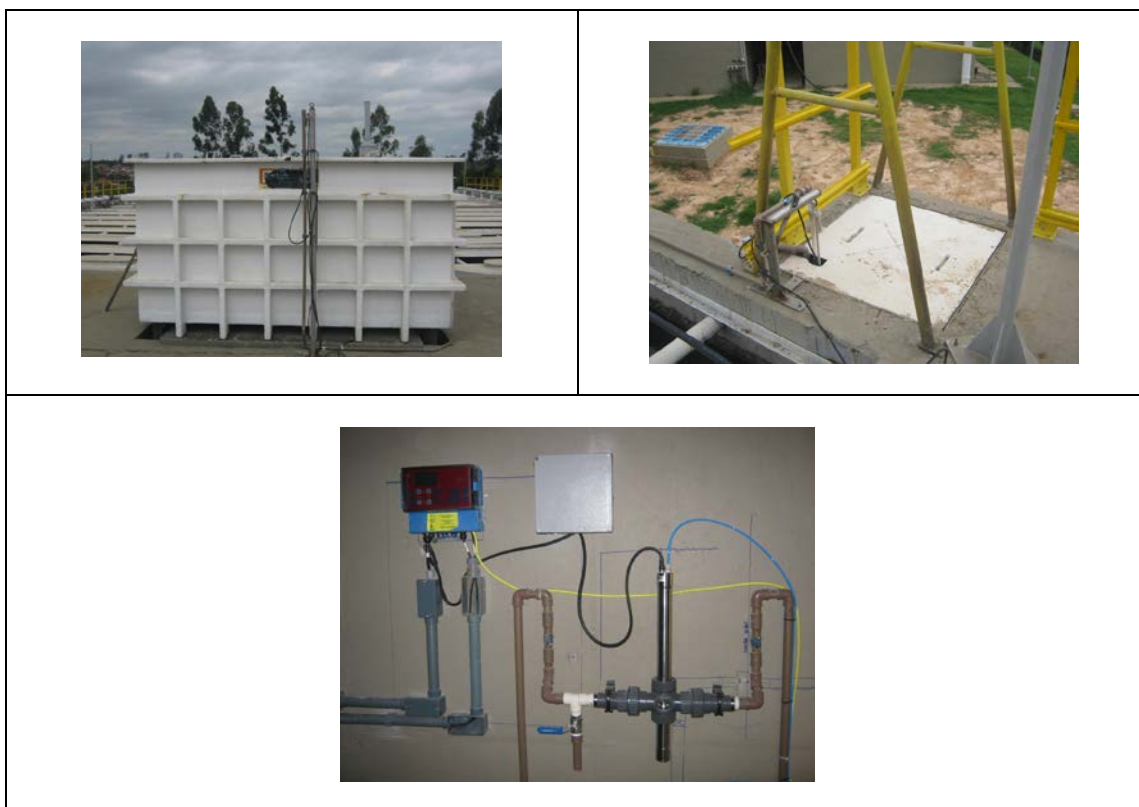
Figuras 6, 7 e 8. Sistema de medição de DQO e pontos de instalação das tomadas de amostras (entrada e saída do reator UASB). Fonte: Arquivo Interno da SANASA
