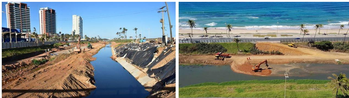
Figura 17: Obras de requalificação do Rio Jaguaribe
