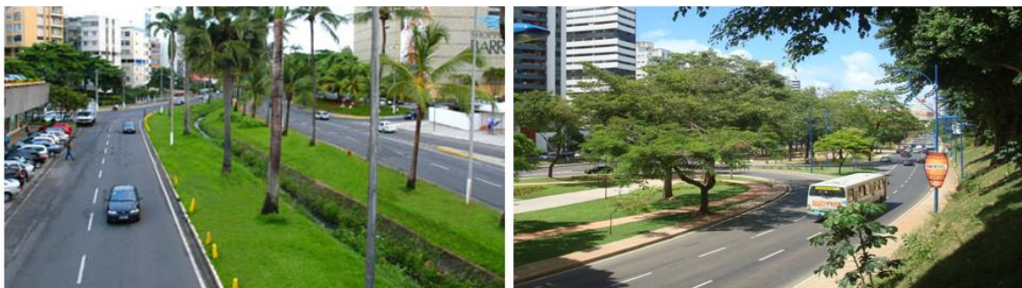
Figura 19: Rio dos Seixos, com seu curso retificado, (à direita). Tamponado e com suas margens concretadas (à esquerda). Av. Centenário.
