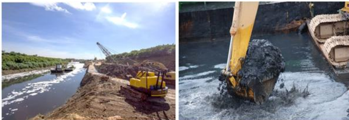
Figura 2: Obras de Desassoreamento do Rio Tietê
