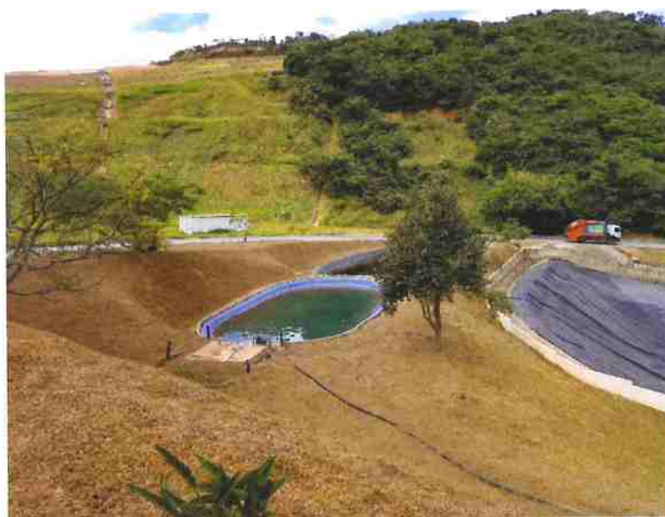
Foto 9 – Lagoa de armazenamento do efluente tratado.
