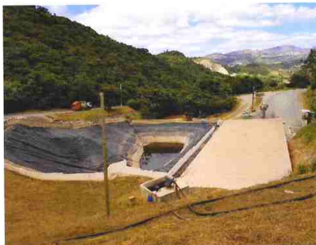
Foto 2 – Lagoa de recepção dos chorumes.
