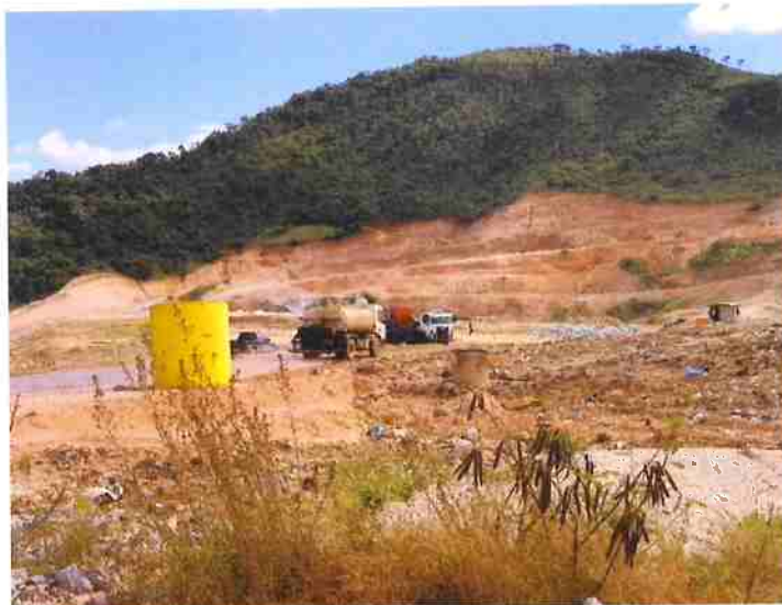
Foto 11 – Utilização do chorume tratado para contenção de poeira.
