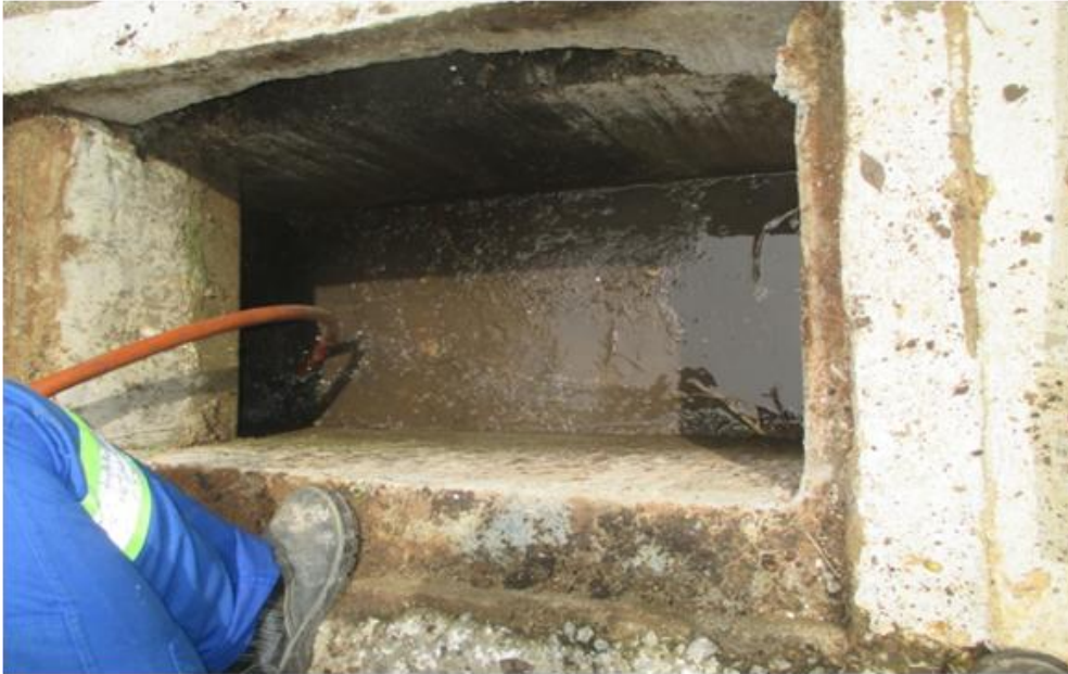
Figura 05 – Exemplo de lavagem de Boca de Lobo.
