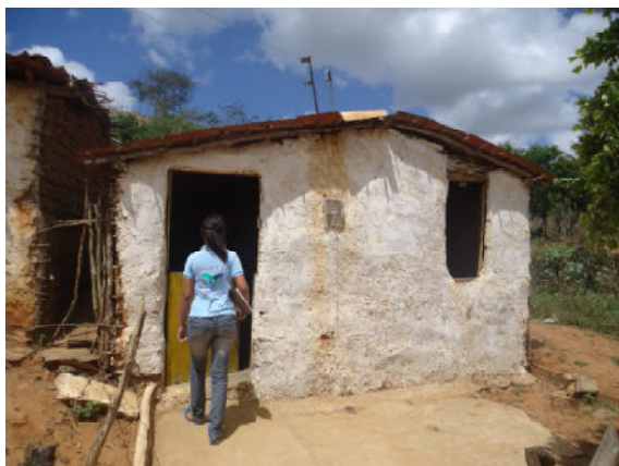
Figura 10: Levantamento de campo de domicílios em condições de vulnerabilidade social na cidade de Santana do Ipanema-AL
