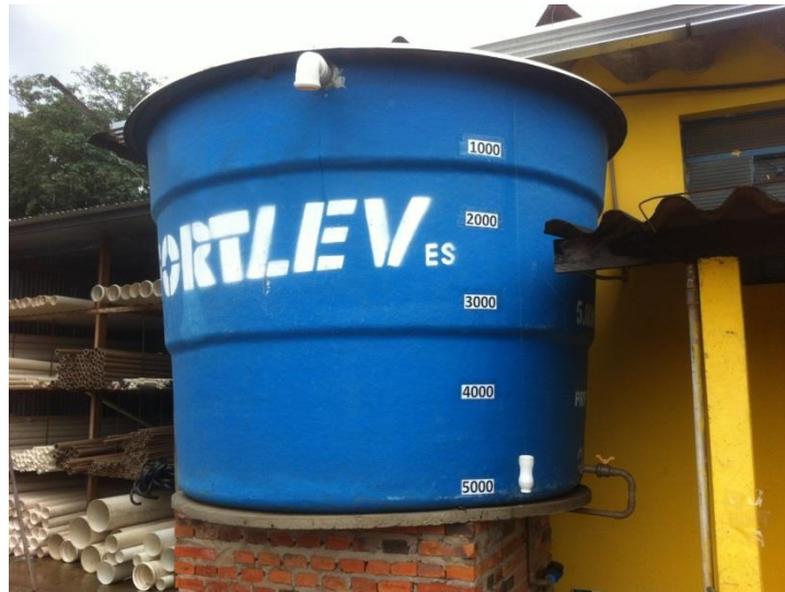
Figura 4 – Dispositivo de indicação do volume armazenado
