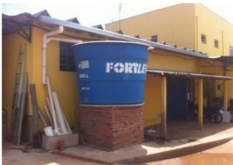
Figura 2 – Vista frontal do sistema de aproveitamento em estudo
