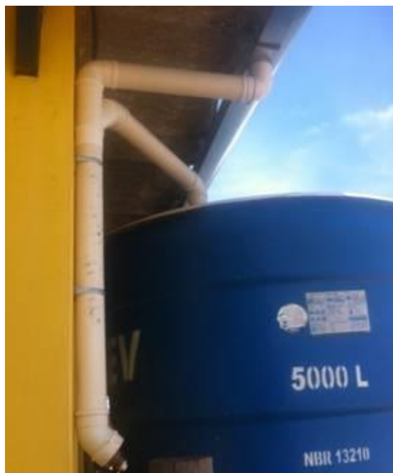
Figura 3 – Dispositivo de descarte da primeira água de chuva
