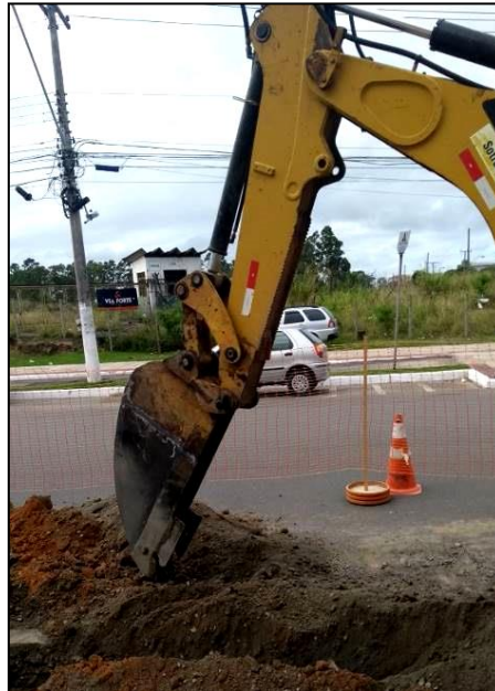
Figura 3 – Retroscavadeira adaptada, vista lateral.
