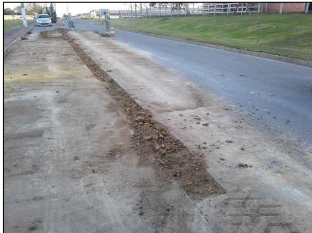
Figura 8 – Ausencia de material após a compactação.
