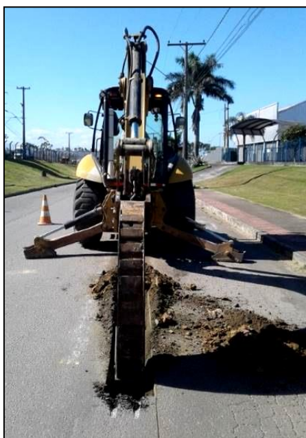
Figura 2 – Retroescavadeira adaptada, vista frontal.
