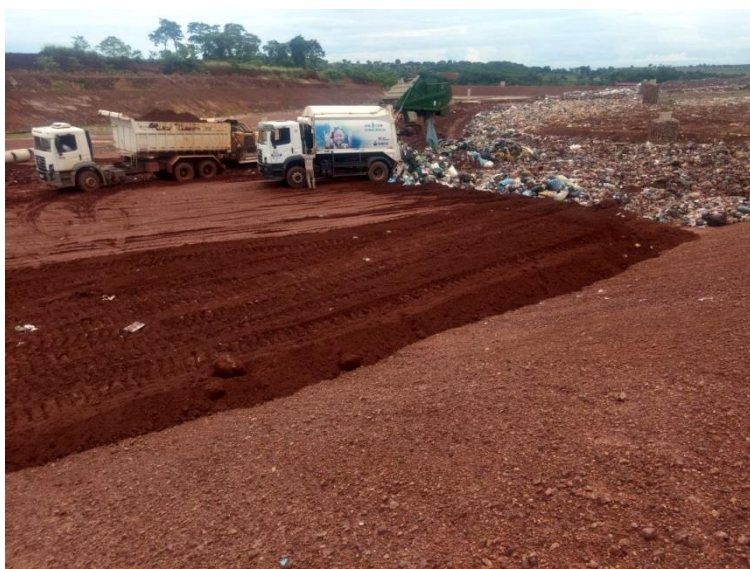
Figura 07– Aterro Sanitário de Rondonópolis
