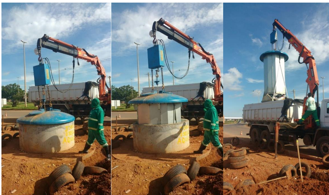
Figura 2 – Fases da coleta em um contêiner semienterrado
