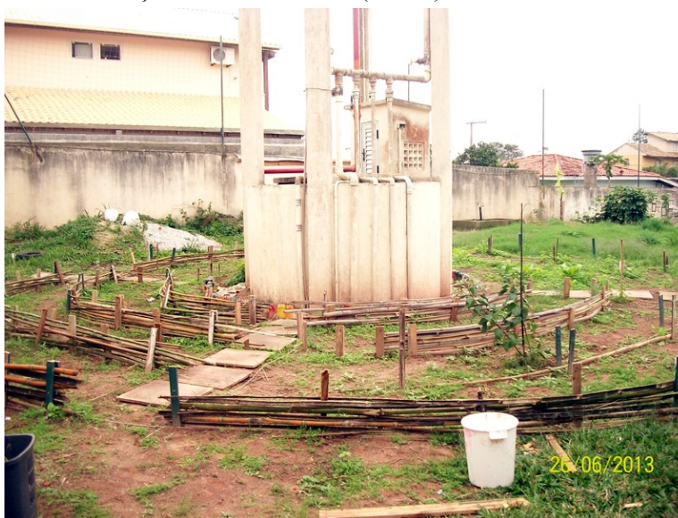
Figura 9: Construção da horta-mandala (zona 1).
