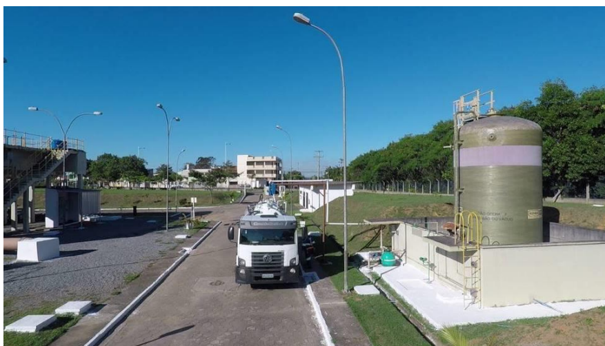
Figura 4. Caixa de capacidade de 45.000 litros para armazenamento da água de reuso.
