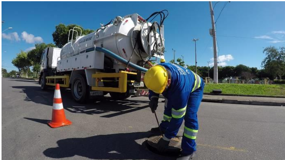
Figura 3. Manutenção na rede coletora de esgoto.
