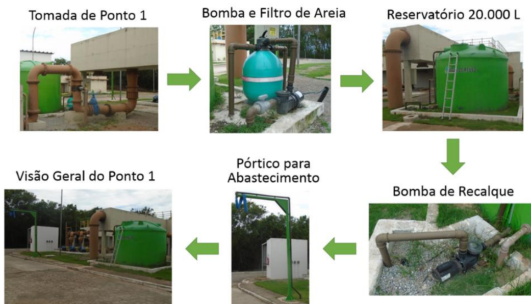
Figura 2. Sistema de tratamento da água de reuso.
