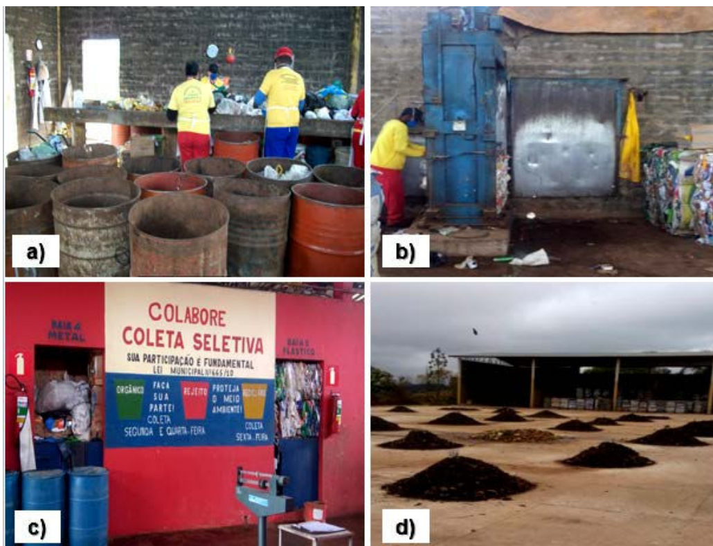
Figura 1 a) Área de triagem com mesa de catação em concreto; b) Área de prensagem do material com prensa hidráulica típica; c) Baias para armazenamento dos recicláveis; d) Pátio de compostagem impermeabilizado (ano de 2016)
