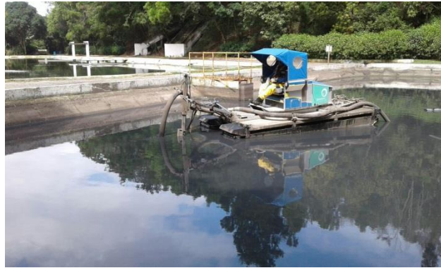
Figura 1 – Máquina anfíbia utilizada na remoção de lodo da lagoa facultativa da ETE Serra Dourada.
