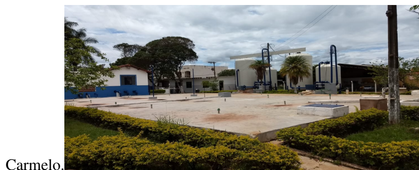
Figura 4 – Estação de Tratamento de Água de Monte
