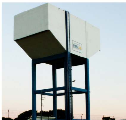
Figura 5 – Reservatório Elevado da Catulina.
