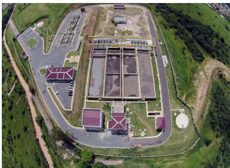
Figura 1 - Vista aérea da EPAR Capivari II (fonte: SANASA)
