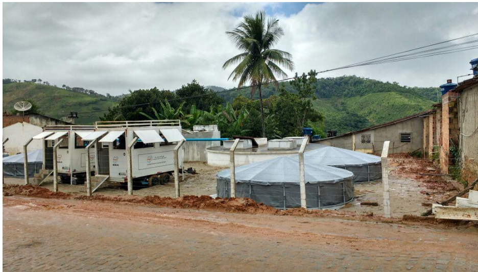
Figura 01: Unidade Móvel de Tratamento de Água (UMTA).
