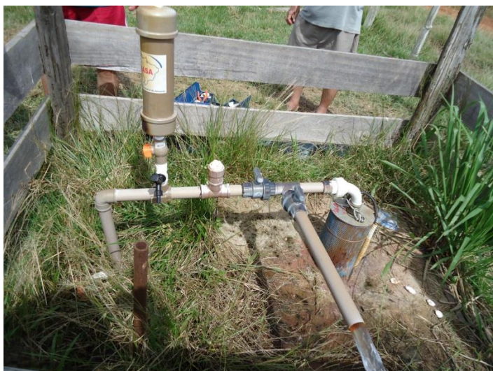
Figuras 2 e 3 – Poço tubular com clorador artesanal e do filtro da Salta-z
