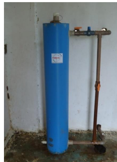
Figuras 2 e 3 – Poço tubular com clorador artesanal e do filtro da Salta-z
