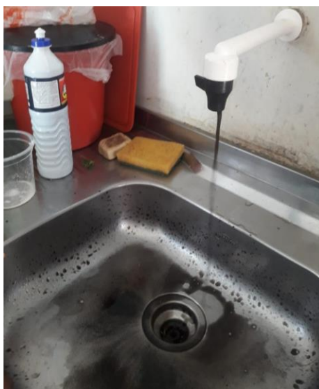
Figura 2 – Água com elevada concentração de manganês, em imóvel localizado em ponta de rede.
