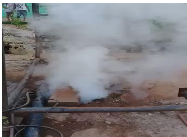
Figura 5 – Higienização do poço com o Ferbax e No Rust.
