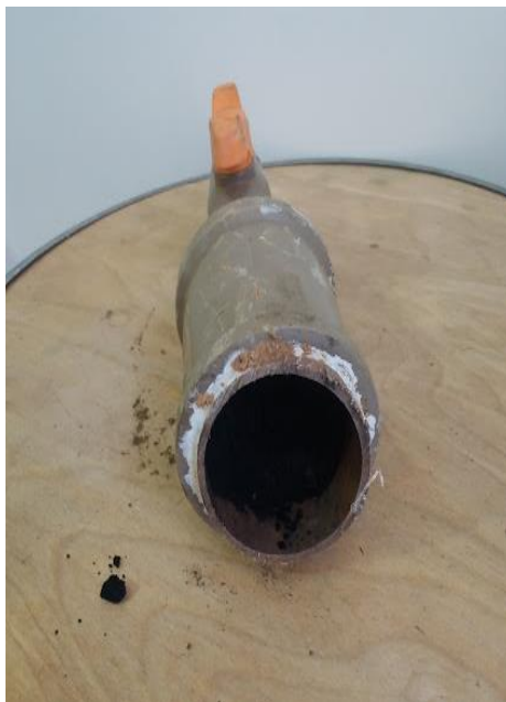
Figura 3 – Tubulação completamente obstruída por depósito de manganês.
