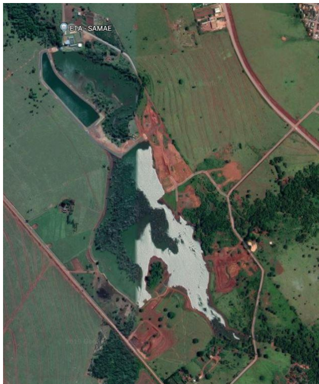
Figura 7 - Reservatórios ETA Queima-pé em maio de 2019.
