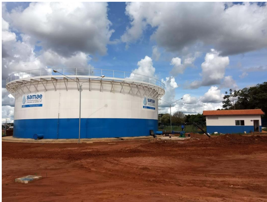
Figura 8 - Reservatório três milhões de litros localizado no bairro Residencial Valência, abril de 2019.
