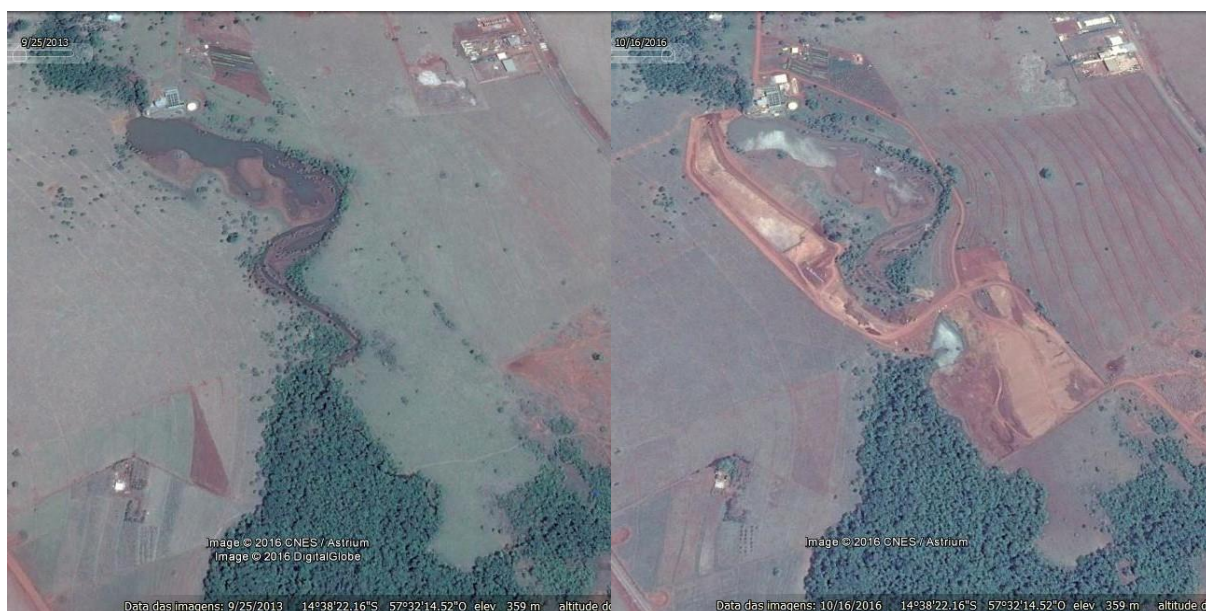
Figura 6 - Reservatórios na ETA Queima-pé em 2013 e 2016, respectivamente, após escavação dos novos reservatórios.
