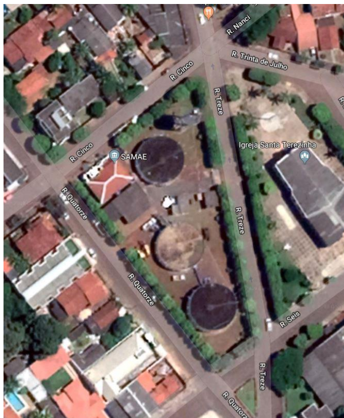
Figura 1 - Conjunto de reservatórios de água tratada localizados no bairro Vila Alta (Google, 2019).
