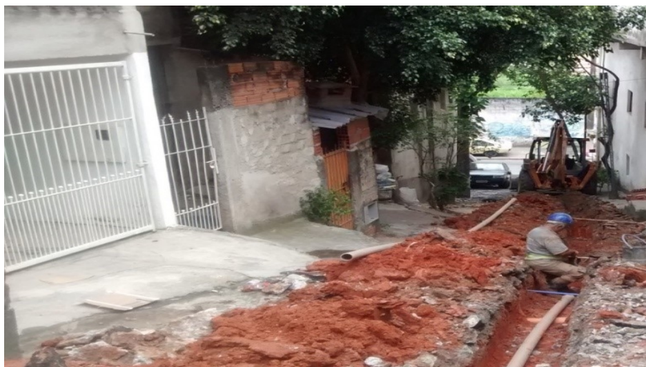
Figura 4 - Rua Dina, durante execução das obras Fonte: Arquivo pessoal
