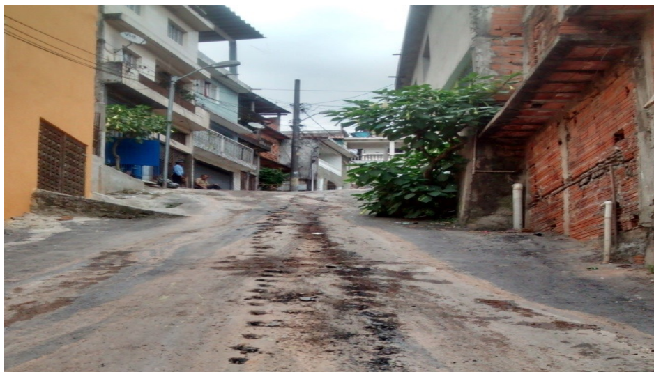
Figura 5 - Rua Alberto Soares da Silva, durante execução das obras Fonte: Arquivo pessoal
