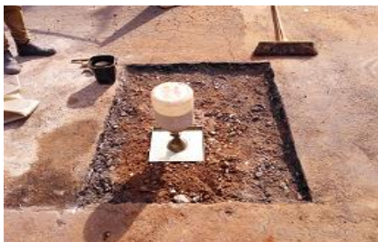
Figura: 4 – Verificação do grau de compactação da camada de base (Autores, 2018)
