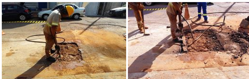
Figura: 3 – Compactação da base de RCC e recorte da capa existente (Autores, 2018)
