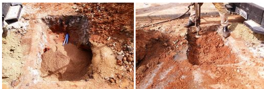
Figura 2: Aplicação da envoltória de areia e camada de reaterro (Autores, 2018)
