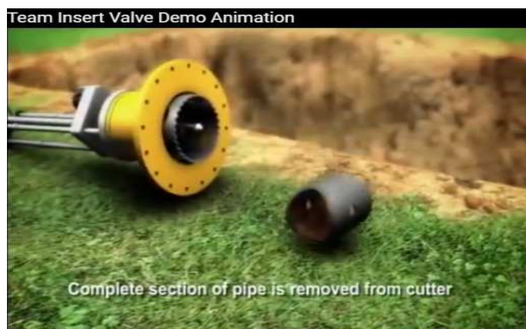
Figura 19 : Verificação da seção completa cortada da tubulação.
