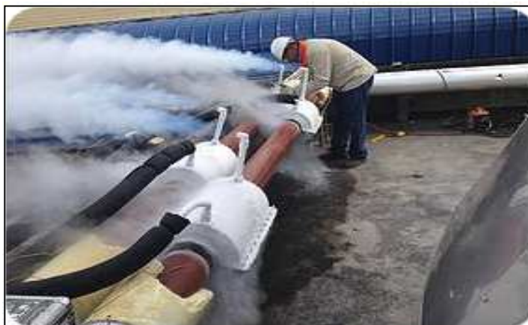
Figura 2 : Trecho sendo isolado por congelamento.
