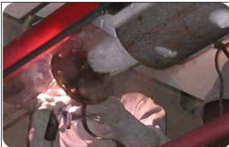
Figura 3 : Trabalho sendo executado em trecho bloqueado.
