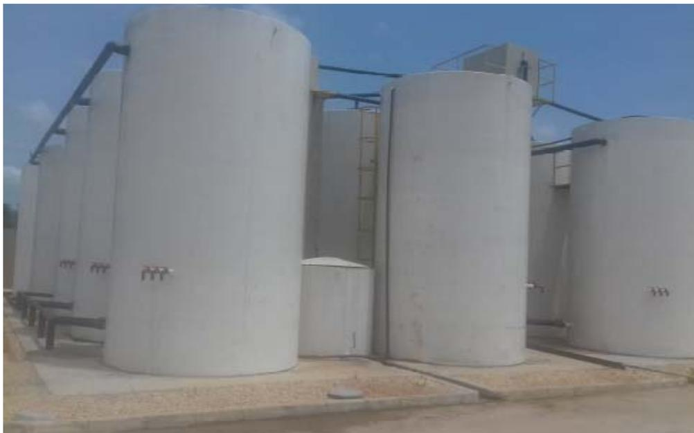
**Figura 05 – Fotos reatores anaeróbios seguidos dos filtros anaeróbios da ETE Viver Melhor Marituba.**
