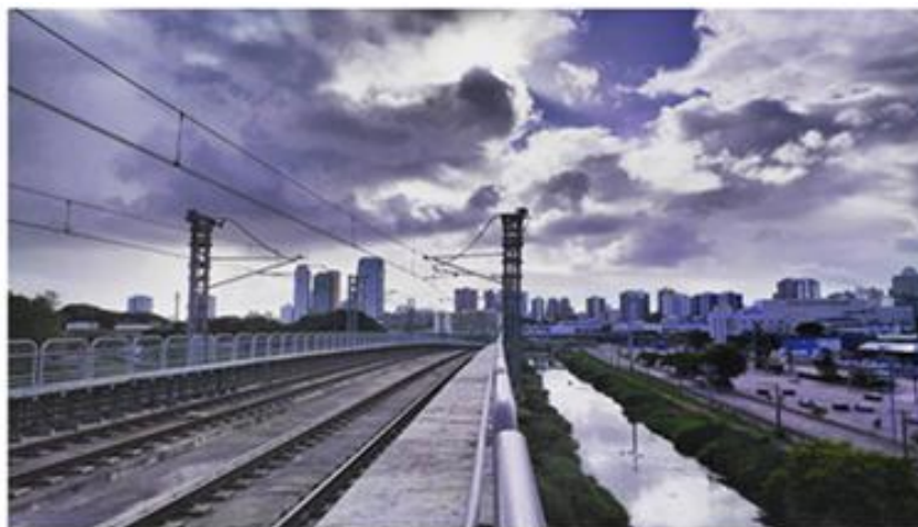
Figura 2: Rio Camarajipe em trecho próximo a Rodoviária de Salvador.
