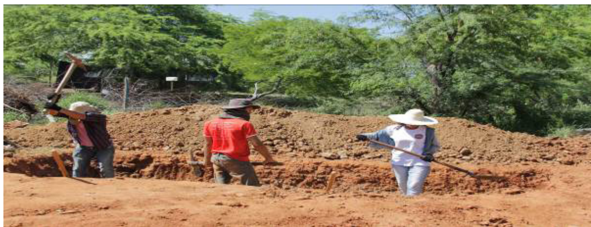
Figura 1: Escavação da trincheira para construção da BET
