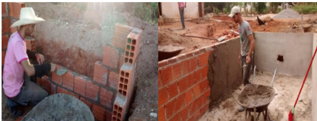
Figura 2: construção das paredes, pisos e reboco.
