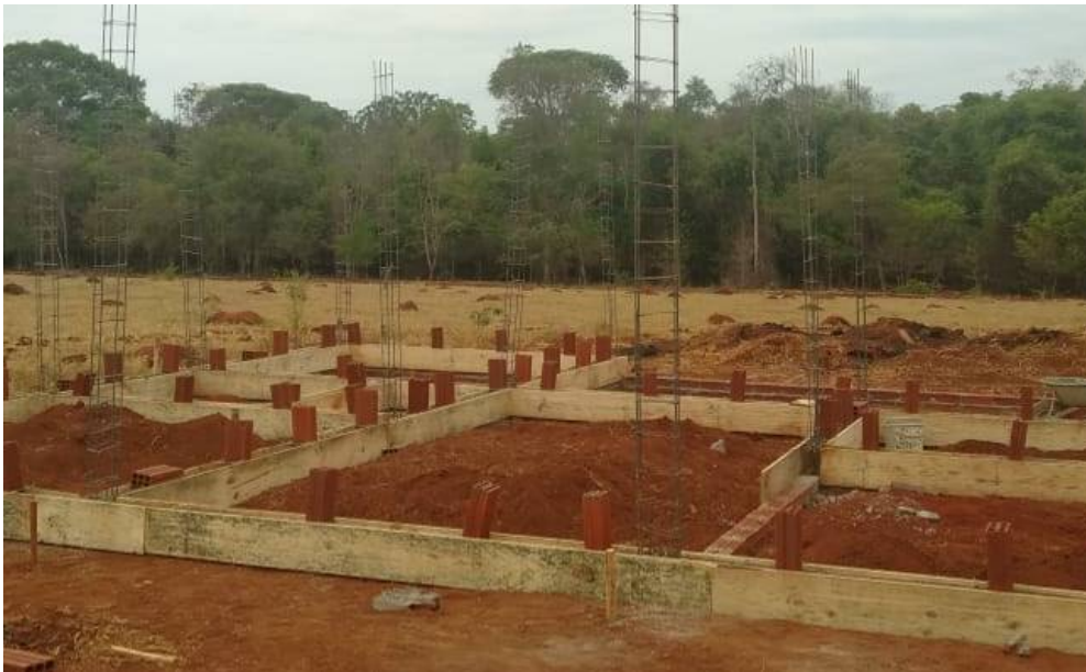
Figura 10: Moradia 1 em construção Jaraguá.
