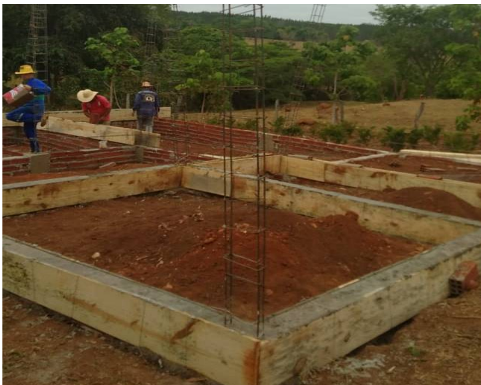
Figura 11: Moradia 2 em construção Jaraguá.
