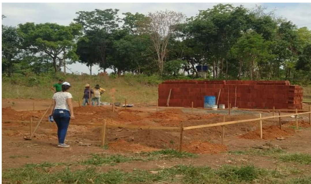
Figura 12: Moradia 3 em construção Jaraguá.
