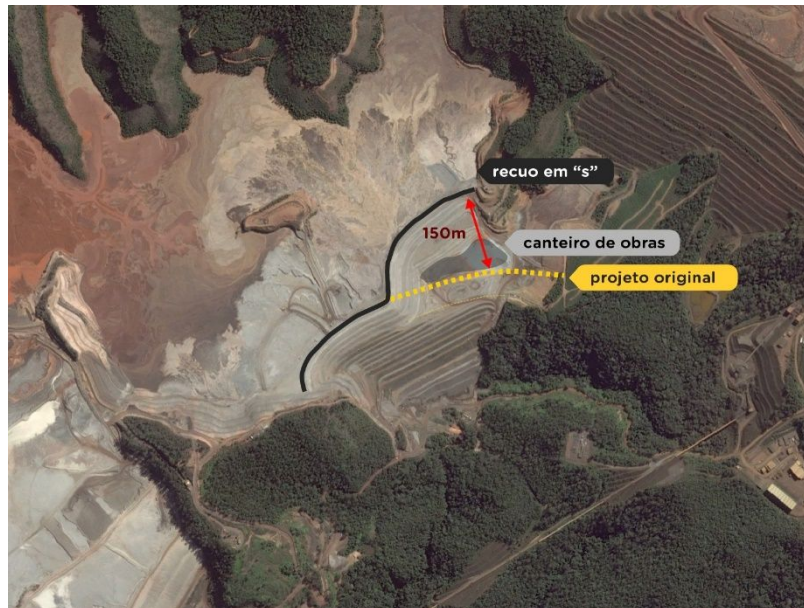
Figura 01: Vista superior da barragem que rompeu. Fonte: Bertoni et. al. (2016)
