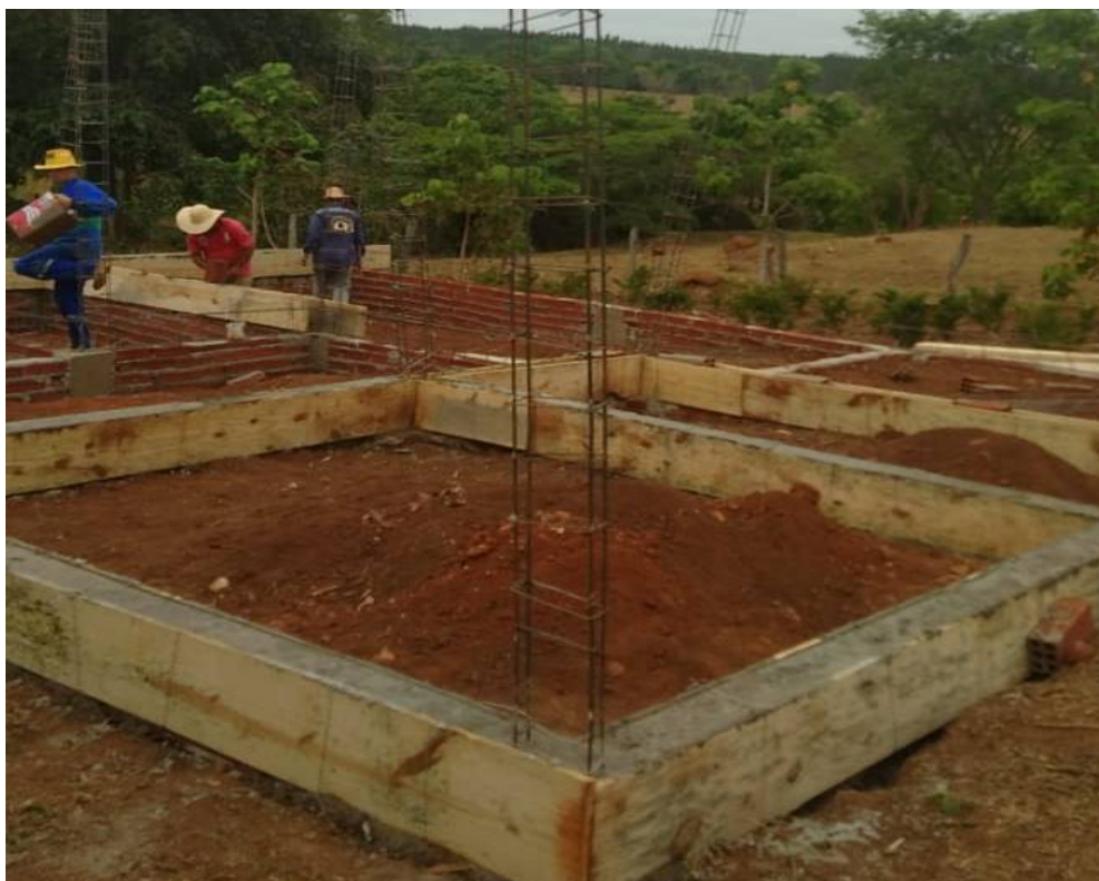
Figura 11: Moradia 2 em construção Jaraguá.
