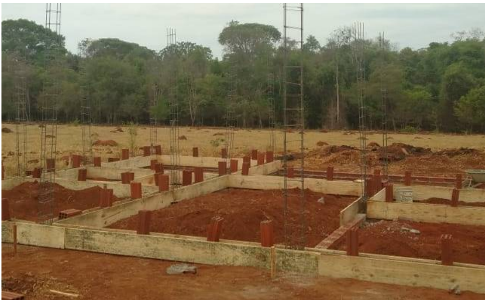
Figura 10: Moradia 1 em construção Jaraguá.
