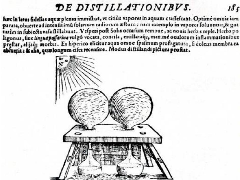
Figura 2.1: O uso da energia solar para destilação por Della Porta [11].
