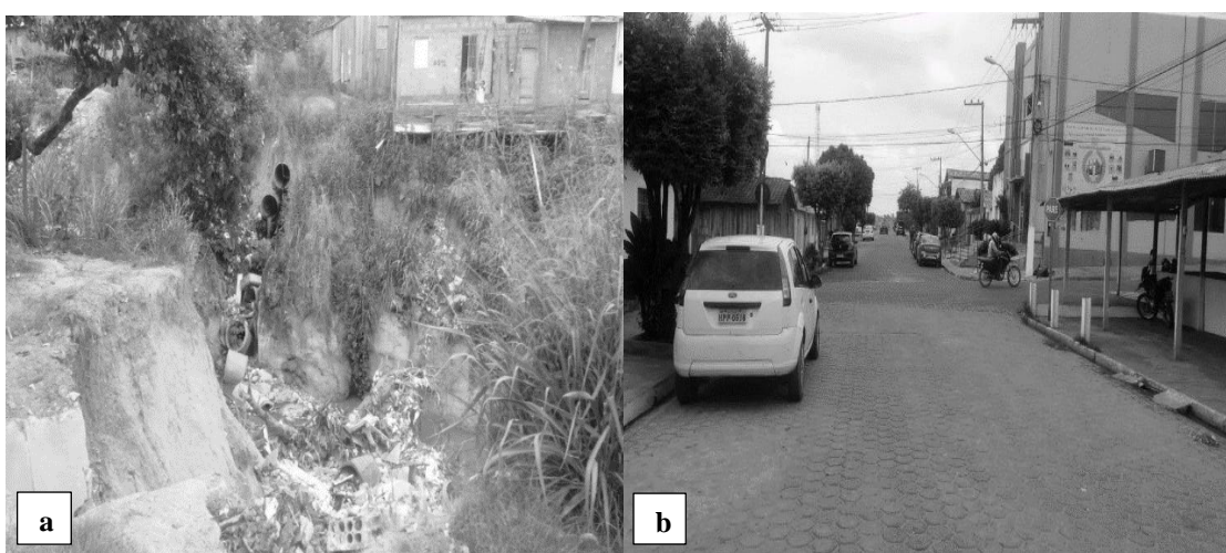
Figura 5: a) Vista frontal da erodibilidade na área 1; b) pavimentação em broquete na área 2. Açailândia – MA
