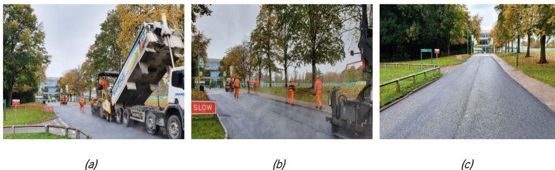
Figura 9 - Exemplo de aplicação de uma mistura betuminosa com ASIC num pavimento (Derek Lewis, 2021)
