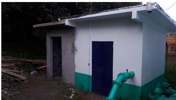
Figura 7. Obras de ampliação da ERAT-4.
